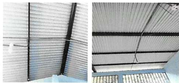
Foto 3: SUSTITUCION DE DUCTO ELECTRICO + ACCESORIOS
