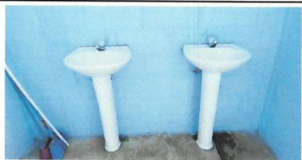
Foto 6: SUSTITUCION DE LAVAMANOS
