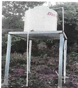
Foto 7: SUSTITUCION DE DEPOSITO DE AGUA 1100 LITROS
