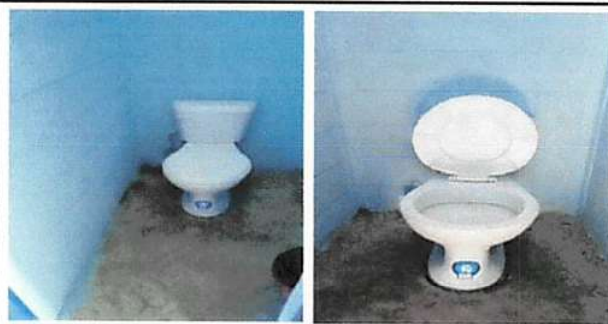
Foto 5: SUSTITUCION DE INODORO
