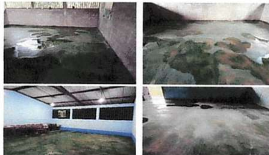
Foto 1: SUSTITUCION DE PISO DE CEMENTO LIQUIDO
