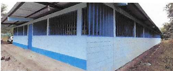
Foto 4: PINTURA EN MUROS, EXTERIORES E INTERIORES
