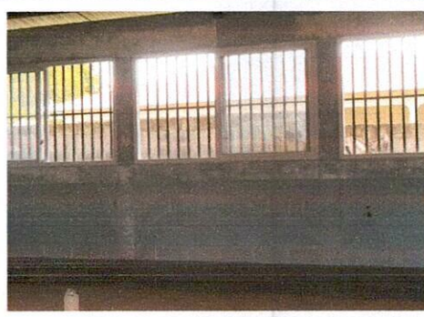
Foto 4: INSTALACIÓN DE VENTANA PVC
