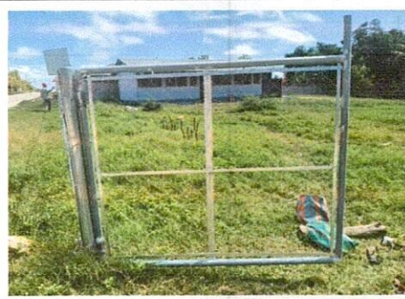
Foto 6: INSTALACIÓN DE PORTÓN CON TUBO GALVANIZADO
