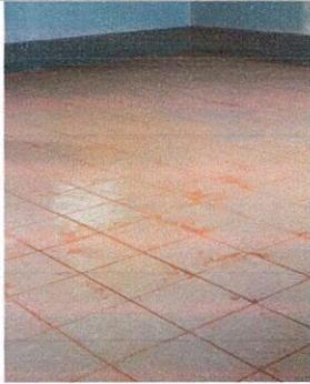
Foto 1: INSTALACIÓN DE PISO CERÁMICO
