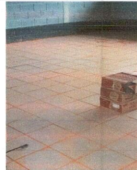
Foto 2: INSTALACIÓN DE PISO CERÁMICO
