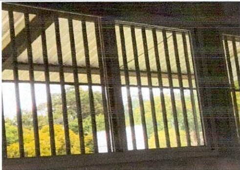
Foto 3: INSTALACIÓN DE VENTANA PVC
