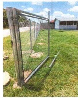
Foto 6: INSTALACIÓN DE PORTÓN CON TUBO GALVANIZADO
