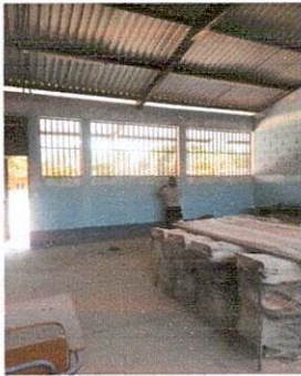
Foto 3: INSTALACIÓN DE VENTANA PVC
