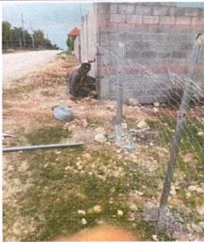
Foto 5: INSTALACIÓN DE MURO PERIMETRAL, DE MALLA Y TUBO GALVANIZADO
