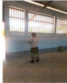
Foto 4: INSTALACIÓN DE VENTANA PVC
