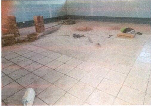
Foto1: INSTALACIÓN DE PISO CERÁMICO
