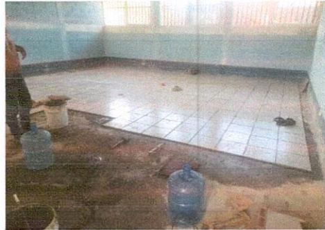
Foto 2: INSTALACIÓN DE PISO CERÁMICO
