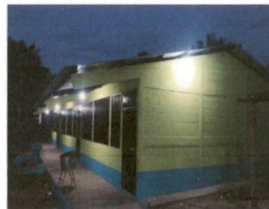
Foto 4: Sustitución de focos ahorradores
