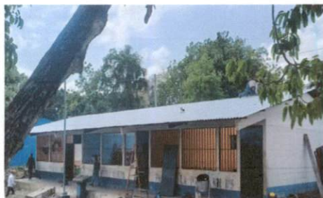
Foto 5: Sustitución de lámina, por lámina troquelada aluzinc calibre 26
