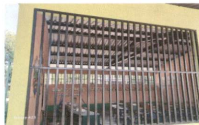
Foto 2: Sustitución de balcones de metal
