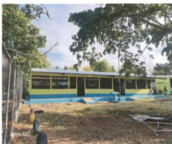
Foto1: Pintura en muros exteriores e interiores
