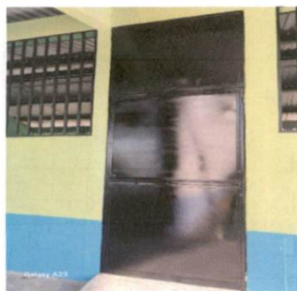
Foto 3: Sustitución de puerta
