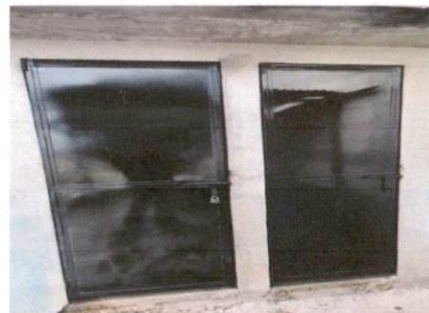
Foto 6: Sustitución de puerta en servicios sanitarios.
