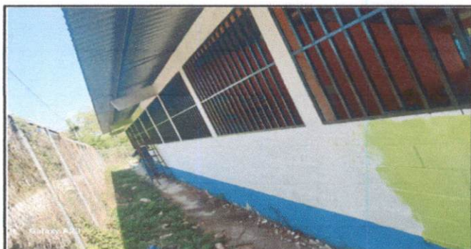
Foto 5: Pintura en muros exteriores e interiores
