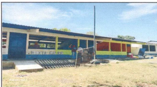
Foto 4: Sustrucción de estructura de metal de ventana
