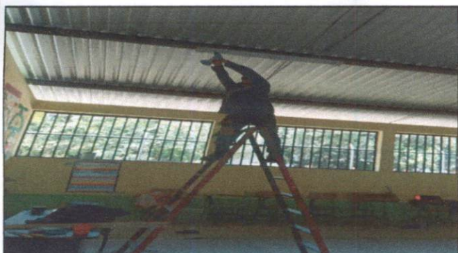
Foto 3: Sustrucción de focos ahorradores/Reparación de cableado eléctrico.
