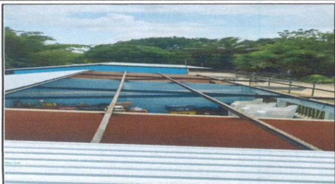
Foto 1: Sustrucción de lámina por lámina troquelada aluzinc
