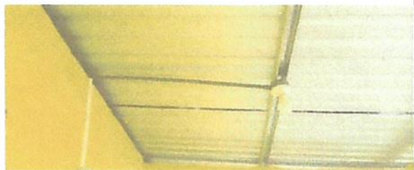
Foto 3: 17.12 Sustitución de ducto eléctrico + accesorio
