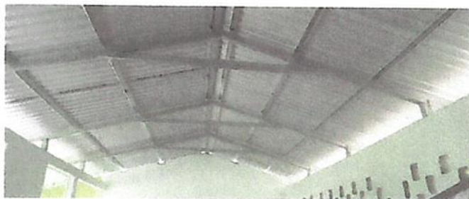
Foto1: 2.2. Sustitución de estructura de madera, por metal
