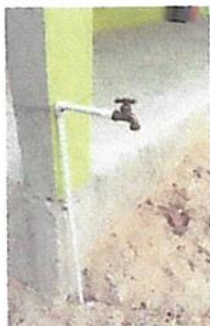
FOTO 1 . Reparacion tubería agua potable
