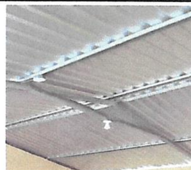
Foto 6: 17.3 Sustitución de lamparas tipo LED
