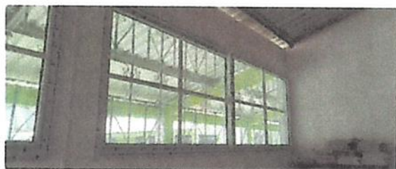
Foto 3: 5.5 Sustitución de vidrio
