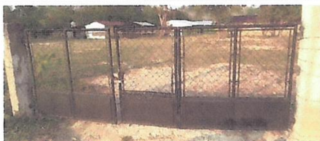
Foto 6: sustitucion de portón
