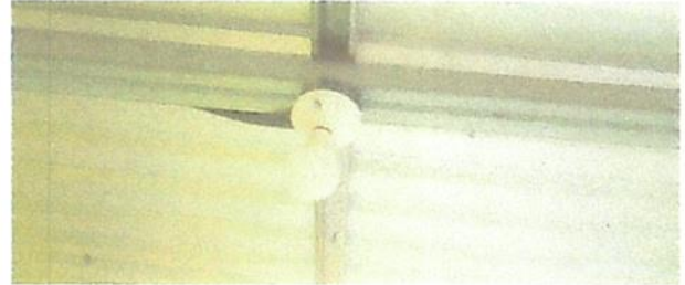
Foto 2: 17.5 Sustitución de plafonera
