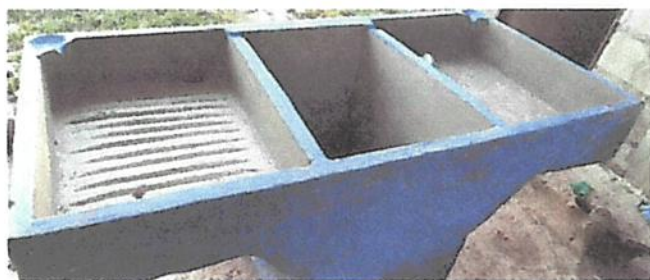
Foto 5: 20.10 Sustitución de cemento de dos lavaderos
