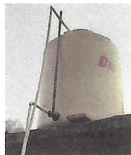
Foto 4: 18.2 Sustitución de depósito de agua 1100 lts
