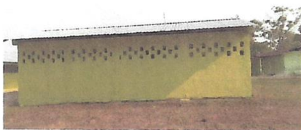
Foto 5: 9.1 Pintura en muros exteriores e interiores
