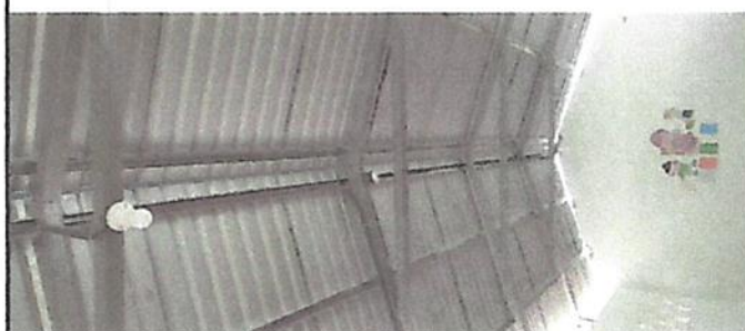
Foto 2: 17.11 Reparación de cableado eléctrico.
