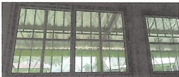
Foto 3: 5.5 Sustitución de vidrio
