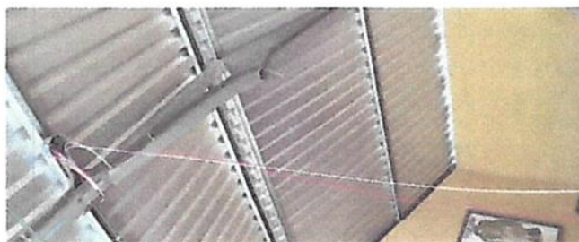
Foto 6: 17.3 Sustitución de lamparas tipo LED
