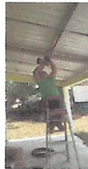
Foto 2: 17.5 Sustitución de plafonera
