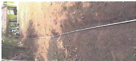
FOTO 1 . Reparacion tuberia agua potable
