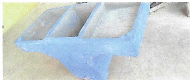
Foto 5: 20.10 Sustitución de cemento de dos lavaderos
