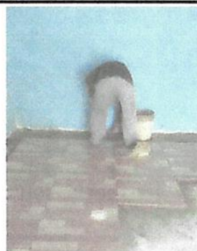
Foto 4: 6.8 Sustitución de piso cerámico
