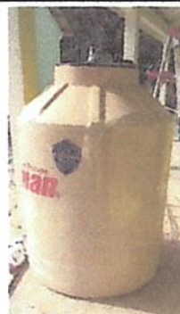
Foto 4: 18.2 Sustitución de depósito de agua 1100 lts
