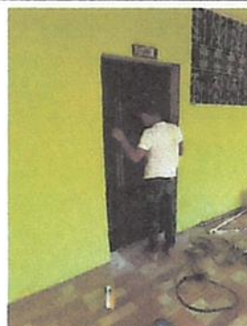
Foto 2: 4.3 Sustitución de puerta
