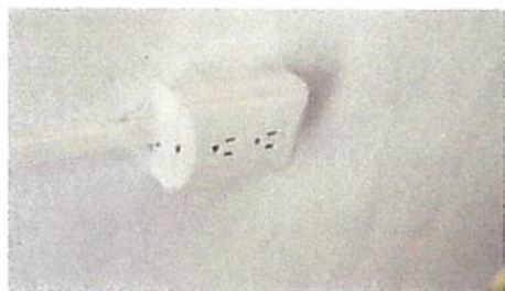
Foto 5: 17.8 Sustitución tomacorrientes dobles
