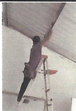
Foto 3: 17.12 Sustitución de ducto eléctrico + accesorio
