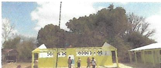
Foto1: 2.2. Sustitución de estructura de madera, por metal
