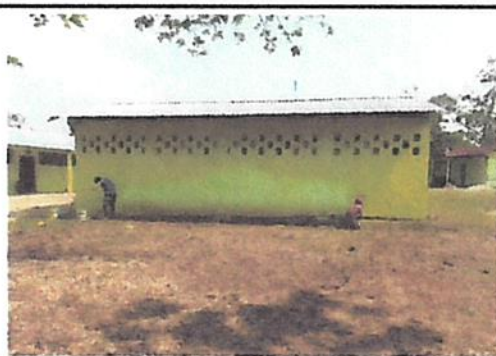
Foto 5: 9.1 Pintura en muros exteriores e interiores
