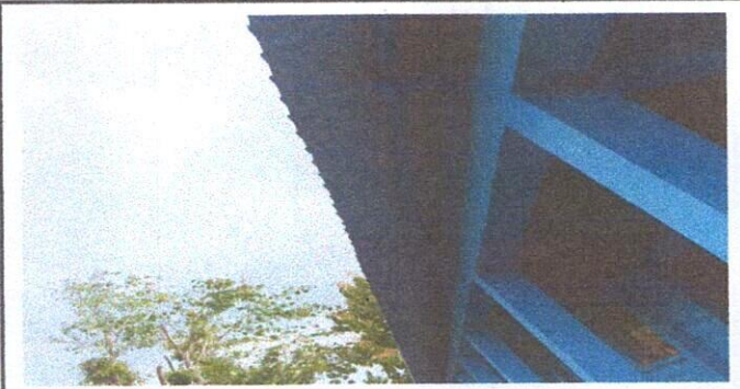
Foto 6: sustitución de elementos de fijación
