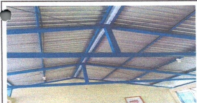
Foto 5: mantenimiento a estructura soporte de metal
