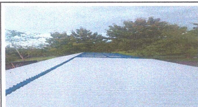
Foto 3: instalación de lámina aluzink
