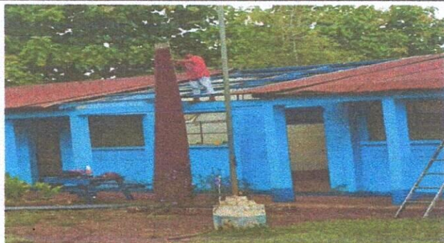
Foto 1: sustitución de lámina por lámina troquelada aluzink calibre 26
