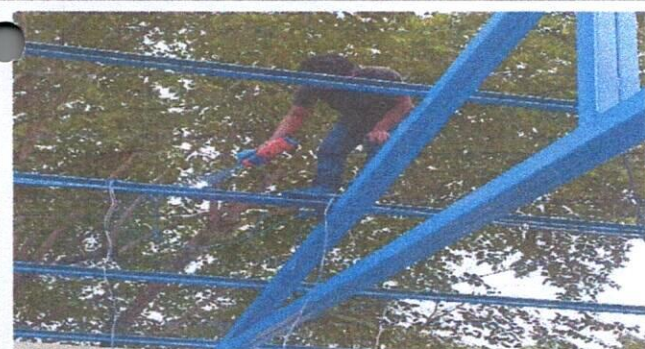
Foto 5: mantenimiento a estructura soporte de metal
