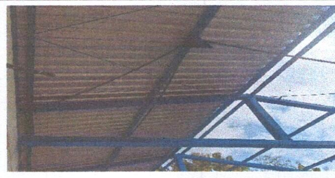
Foto 6: sustitución de elementos de fijación
