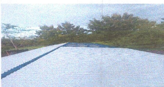
Foto 4: sustitución de capotes para lámina troquelada
