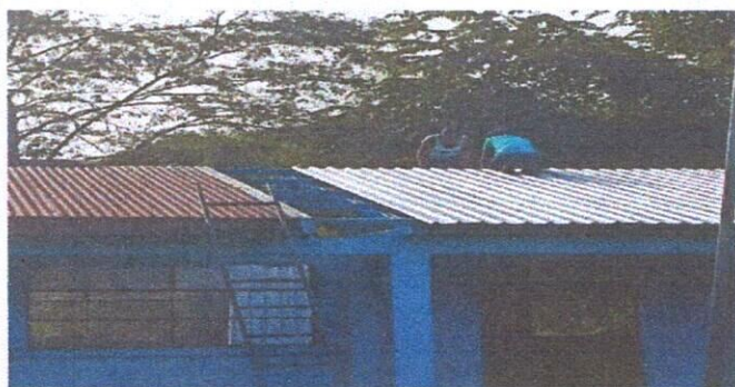
Foto 3: instalación de lámina aluzink
