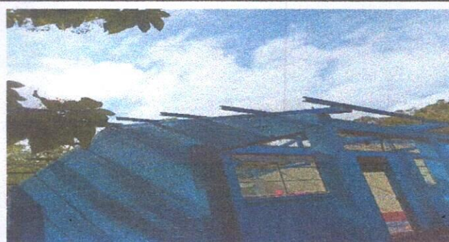
Foto 2: desinstalación de lámina existente
