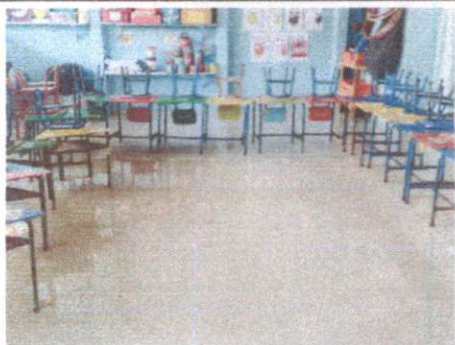
Sustitución de piso
