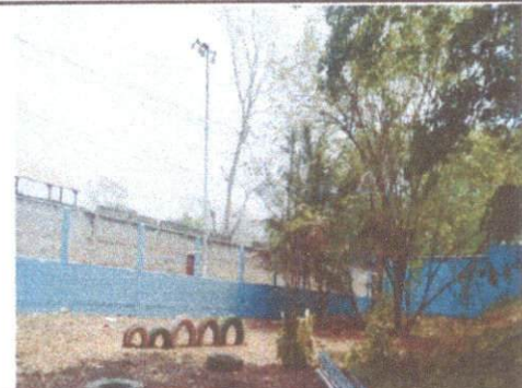
Sustitución de Pintura interior y exterior
