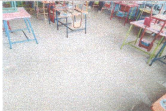
Sustitución de piso
