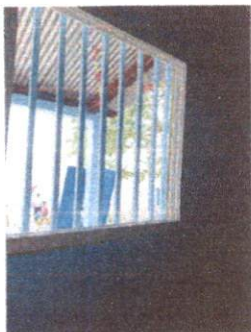
Sustitución de ventana dirección
