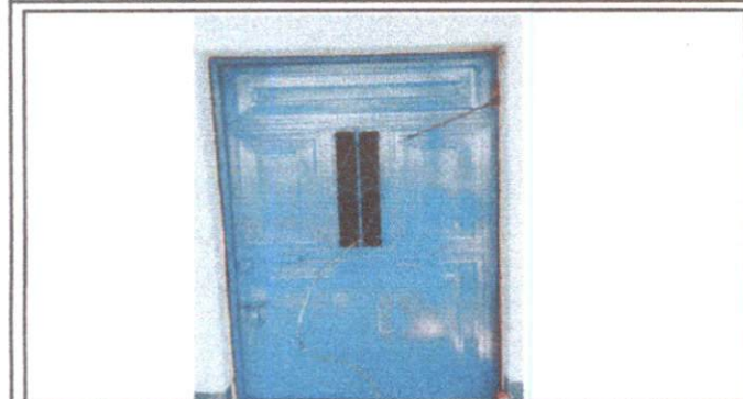
Sustitución de Puerta
