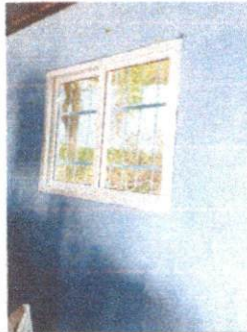
Sustitución de ventanas dirección
