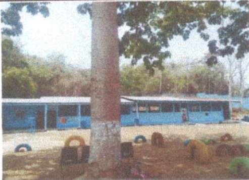
Sustitución de Pintura interior y exterior
