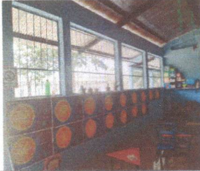
Sustitución de Pintura interior y exterior
