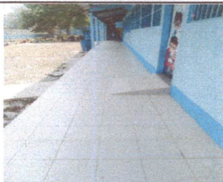
Sustitución de piso
