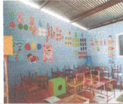
Sustitución de Pintura interior y exterior
