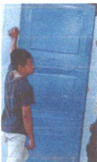
Sustitución de puertas de dirección
