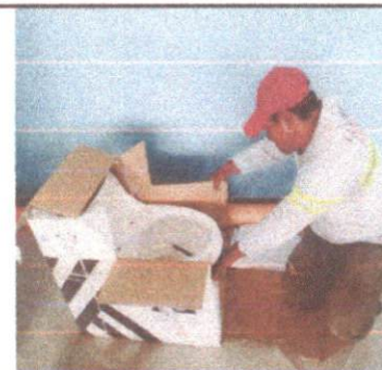
Sustitución de inodoro
