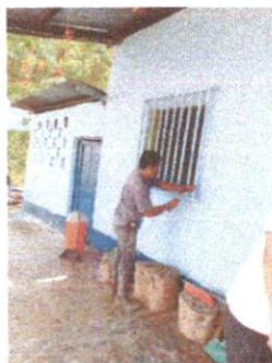
Sustitución de ventana dirección
