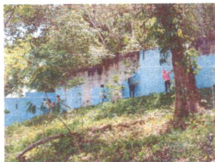
Sustitución de Pintura interior y exterior Muralla
