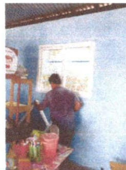
Sustitución de ventana dirección
