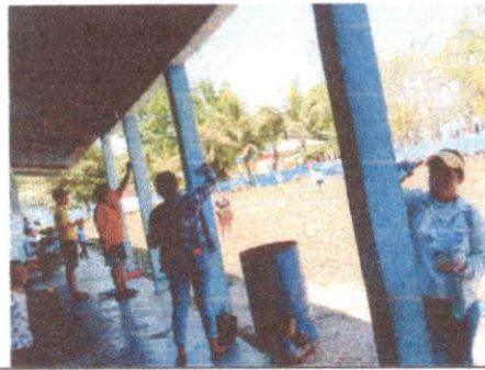
Sustitución de Pintura de interior y exterior de aulas
