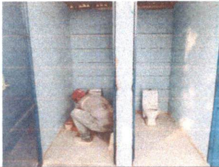
Sustitución de Piso del baño
