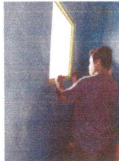
Sustitución de ventanas dirección
