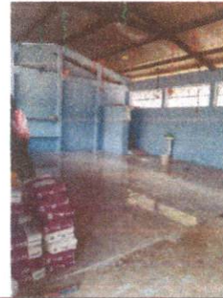
Sustitución de piso interior de aulas
