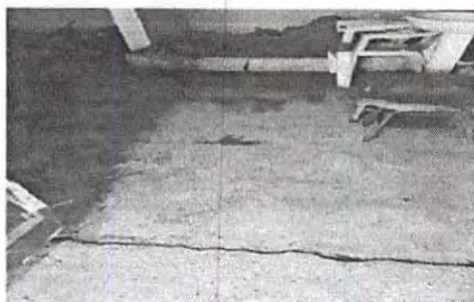
Sustitución de piso interior de cocina
