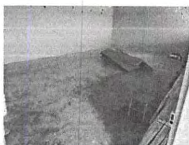
Sustitución de piso interior de aulas
