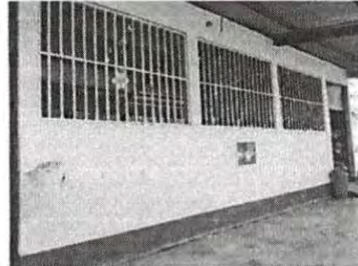
Sustitución de Pintura de interior y exterior de aulas
