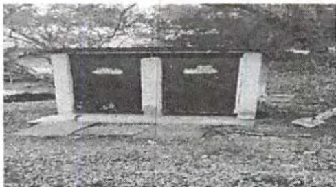
Sustitución de puertas de baños
