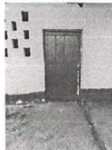
Sustitución de puertas de cocina
