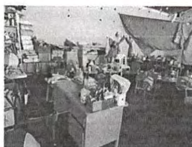
Sustitución de piso interior de aulas
