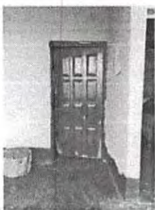
Sustitución de puerta de dirección
