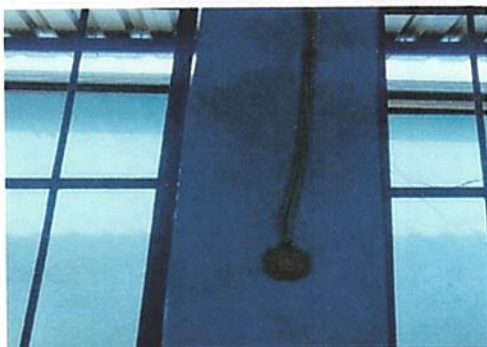
Foto 3: Sustrucción interruptores simples.
