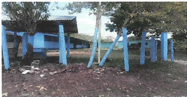
Foto 1: Reparación de malla galvanizada.
