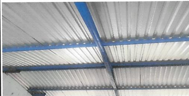
Foto 2: Mantenimiento a estructura de soporte de metal.
