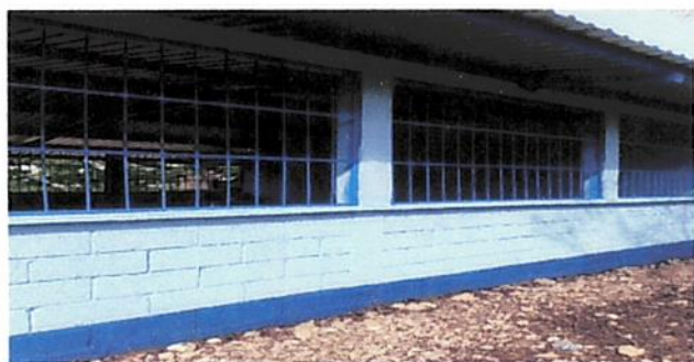
Foto 3: Sustrucción de balcones de metal.
