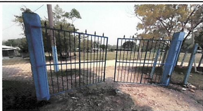
Foto 1: Sustrucción de porton de metal.
