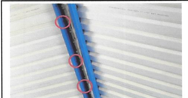
Foto 6: Sustitución de elementos de fijación.
