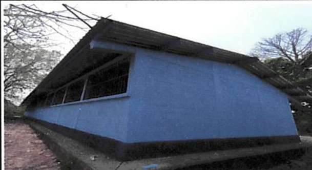
Foto 6: Pintura de muros exteriores e interiores.
