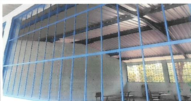
Foto 3: Mantenimientos a balcones de metal.
