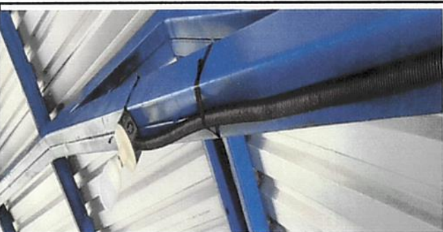
Foto 5: Sustitución de focos ahorradores.
