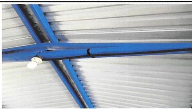
Foto 2: Sustrucción de plafoneras
