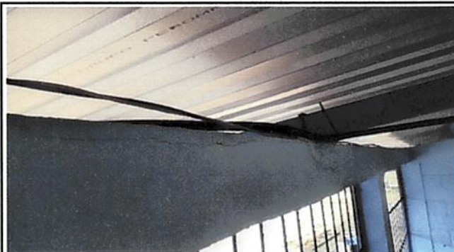
Foto 2: Reparación de cableado eléctrico.
