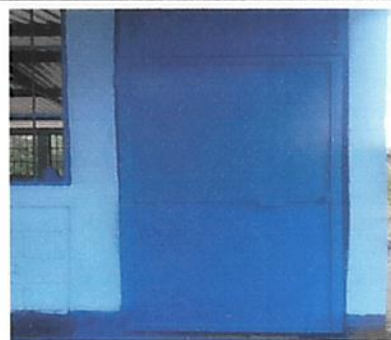
Foto 4: Sustrucción de puertas de metal.
