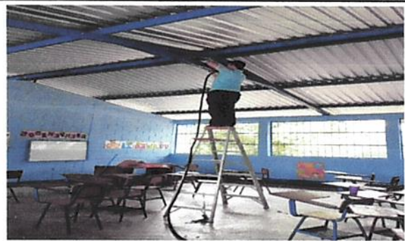
Foto 2: Reparación de cableado eléctrico.
