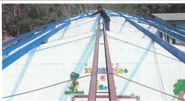
Foto 2: Mantenimiento a estructura de soporte de metal.
