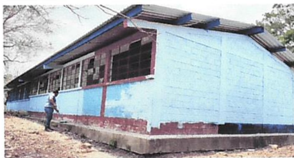
Foto 6: Pintura de muros exteriores e interiores.
