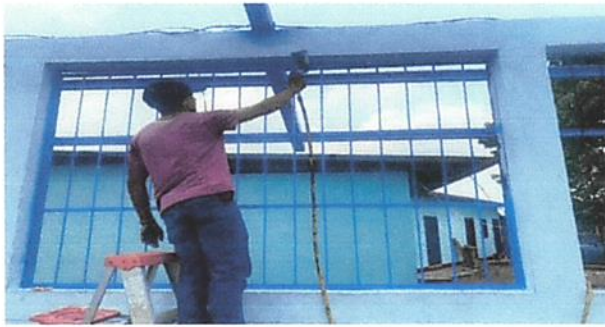
Foto 3: Mantenimientos a balcones de metal.
