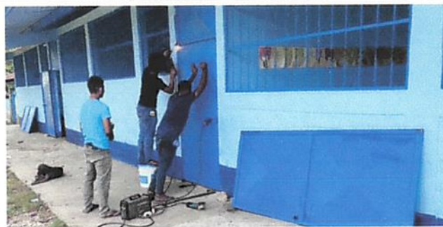
Foto 4: Sustitución de puertas de metal.
