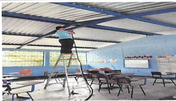
Foto 2: Sustitución de plafoneras.
