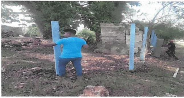
Foto1: Reparación de malla galvanizada.
