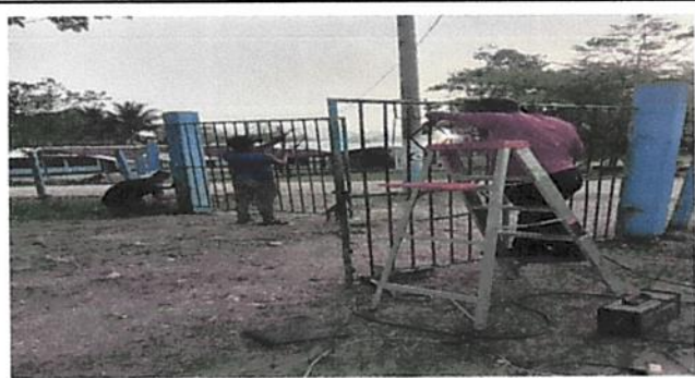
Foto 1: Sustitución de portón de metal.
