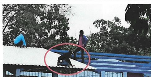
Foto 6: Sustitución de elementos de fijación.
