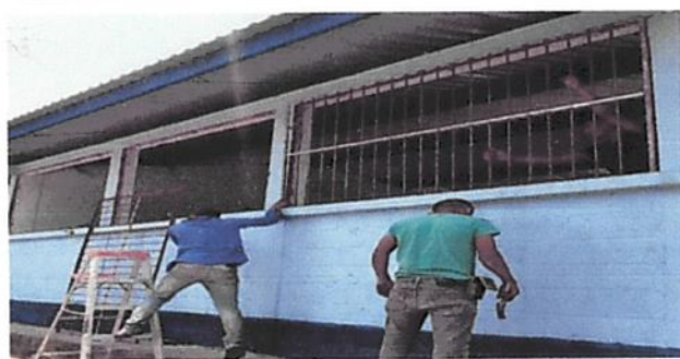
Foto 3: Sustitución de balcones de metal.
