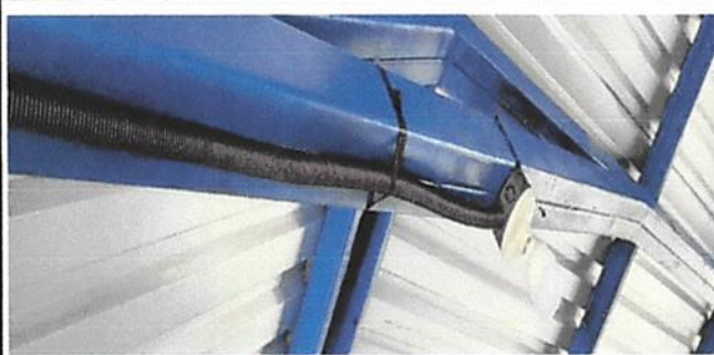
Foto 5: Sustitución de focos ahorradores.
