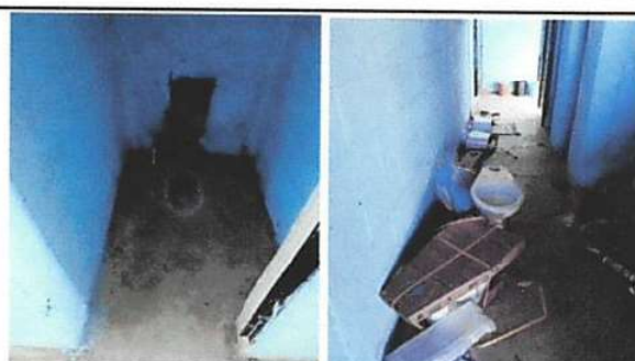
Foto 4: Sustrución de inodoro
