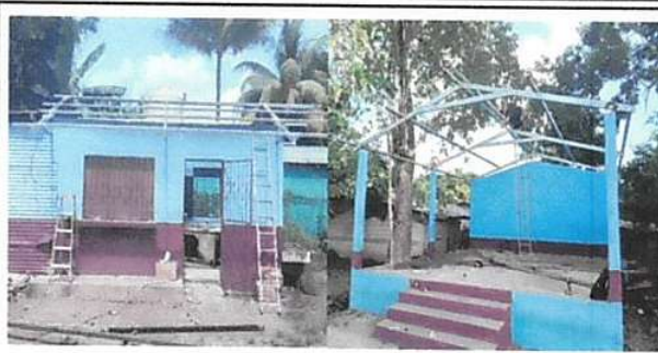
Foto 2: Sustrución de estructura de soporte de madera, por metal
