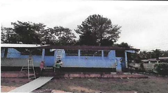
Foto 1: Sustrución de lámina, por lamina troquelada aluzinc calibre 26
