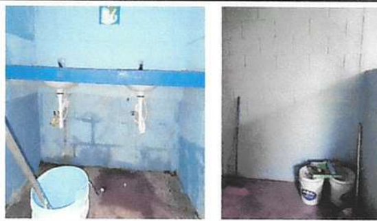
Foto 8: pintura en muros exteriores e interiores
