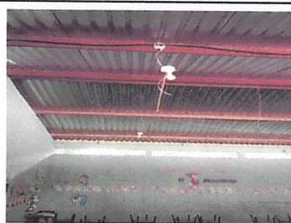
Foto 6: sustitucion de lampara de 2x40
