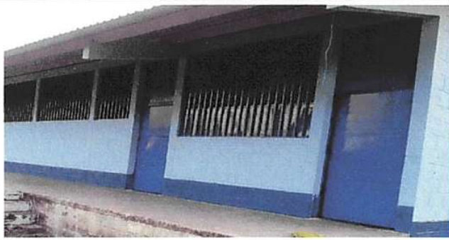
Foto 1: 4. Puertas de metal: 4.3 Sustitución de puerta.
