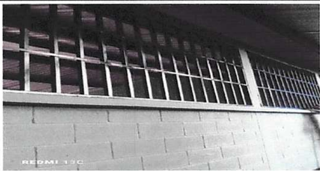
Foto 3: 5. Ventanas: 5.6 Sustitución de balcones de metal.
