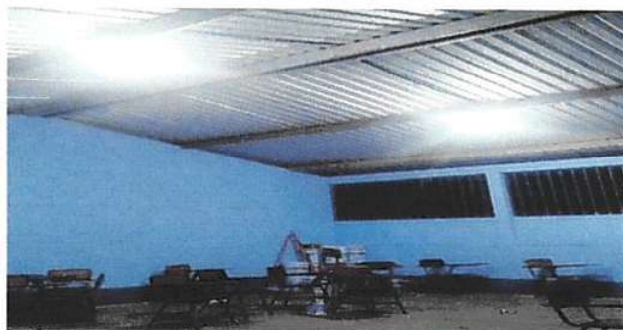
Foto1: 17. Reparación de Sistema Eléctrico: 17.4 Sustitución de focos ahorradores
