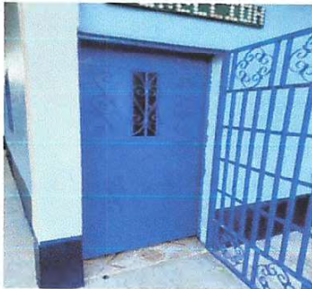
Foto 5: Mantenimiento a estructura
