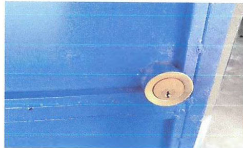
Foto 6: Sustitución de chapa
