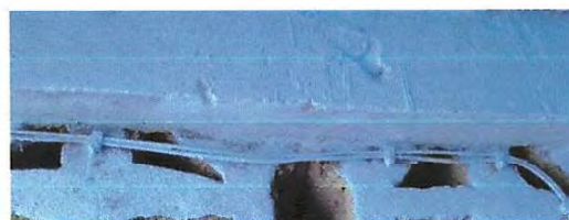
Foto 18: Sustitución de ducto eléctrico + accesorios
