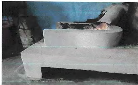
Foto 19: Reparación de chimenea de concreto
