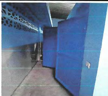
Foto 11: Mantenimiento a estructura
