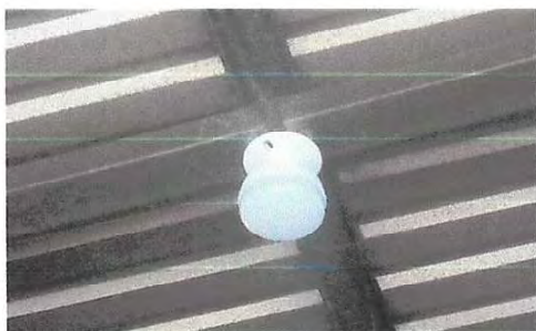
Foto 15: Sustitución de focos ahorradores
