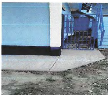
Foto 9: Reparación de banqueta de concreto
