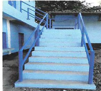
Foto 14: Mantenimiento a barandas de metal
