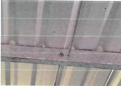
Foto 3: Sustitución de elementos de fijación
