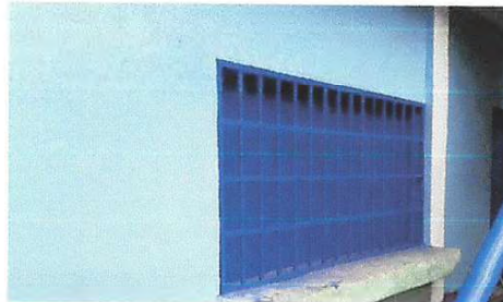
Foto 8: Mantenimiento a balcones de metal
