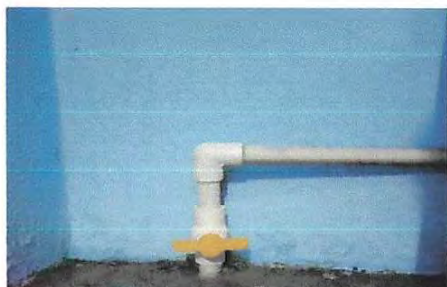
Foto 13: Sustitución de llave de paso
