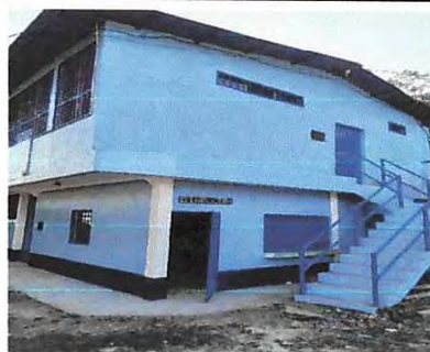
Foto 10: Pintura en muros exteriores e interiores
