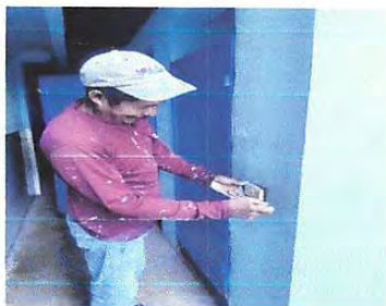
Foto 17: Sustitución de interruptores simples
