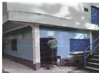
Foto 10: Pintura en muros exteriores e interiores
