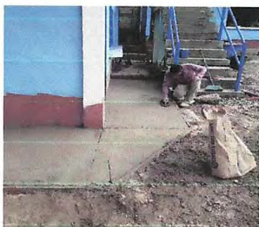
Foto 9: Reparación de banqueta de concreto
