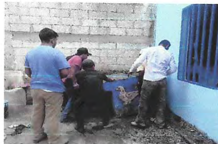
Foto 20: Sustitución de pila de cemento de dos lavaderos
