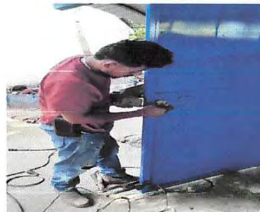
Foto 6: Sustitución de chapa
