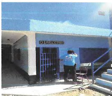
Foto 5: Mantenimiento a estructura
