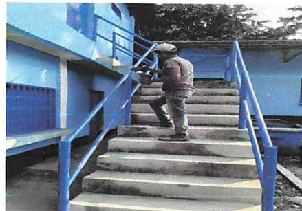
Foto 14: Mantenimiento a barandas de metal
