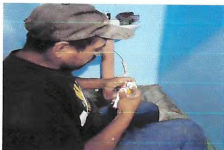
Foto 13: Sustitución de llave de paso
