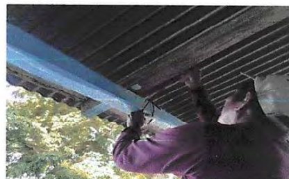
Foto 18: Sustitución de ducto eléctrico + accesorios
