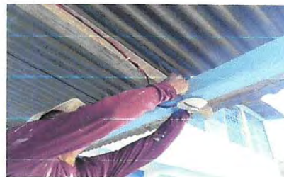
Foto 16: Sustitución de plafoneras
