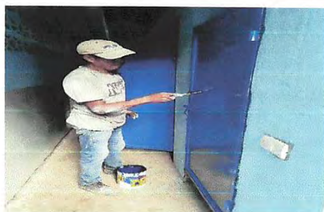
Foto 11: Mantenimiento a estructura
