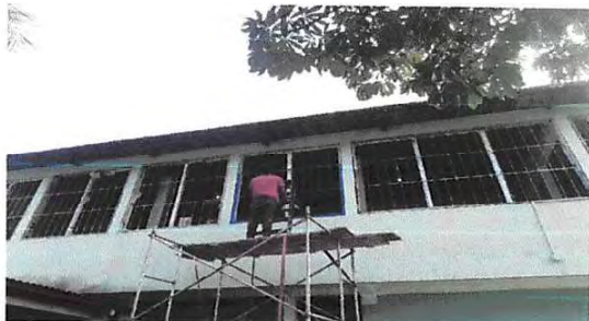
Foto 7: Mantenimiento a marcos mill finish
