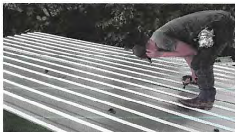
Foto 3: Sustitución de elementos de fijación
