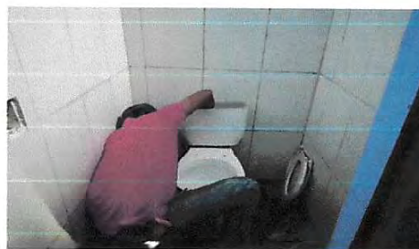
Foto 12: Sustitución de accesorios de inodoro
