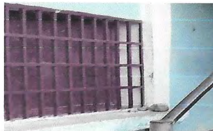
Foto 8: Mantenimiento a balcones de metal
