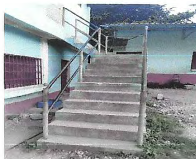
Foto 14: Mantenimiento a barandas de metal
