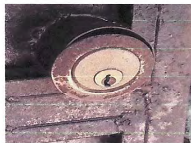
Foto 6: Sustitución de chapa
