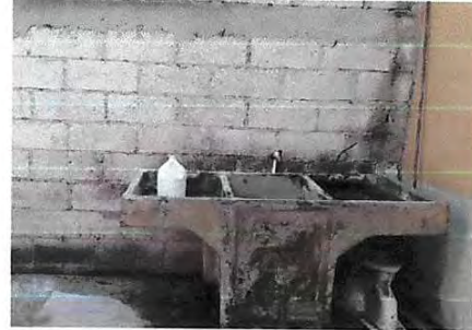
Foto 20: Sustitución de pila de cemento de dos lavaderos
