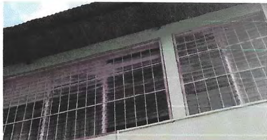
Foto 7: Mantenimiento a marcos mill finish
