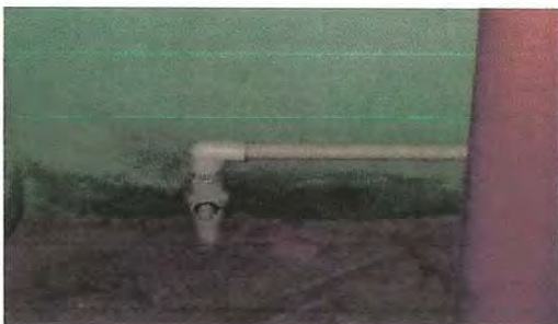
Foto 13: Sustitución de llave de paso
