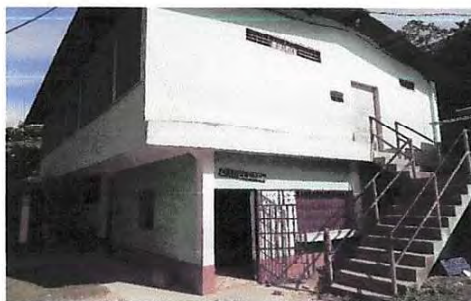
Foto 10: Pintura en muros exteriores e interiores
