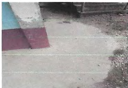
Foto 9: Reparación de banqueta de concreto
