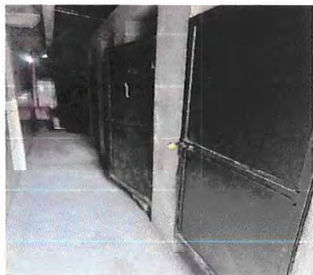
Foto 11: Mantenimiento a estructura
