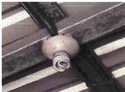
Foto 15: Sustitución de focos ahorradores
