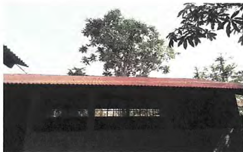
Foto 1: sustitución de lámina, por lamina troquelada aluzinc calibre 26
