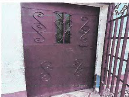
Foto 5: Mantenimiento a estructura
