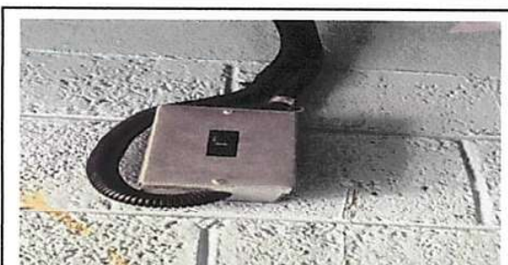
Foto 10: Sustitución de tablero de flipones
