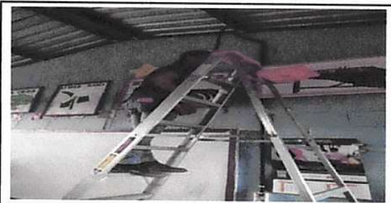
Foto 5: Sustitución de focos ahorradores
