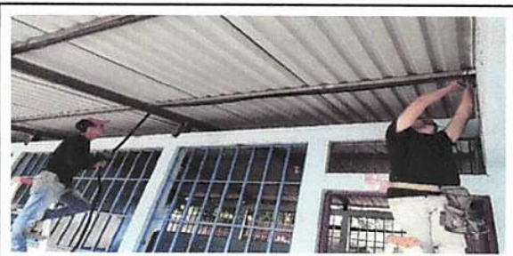
Foto 11: Reparación de cableado eléctrico
