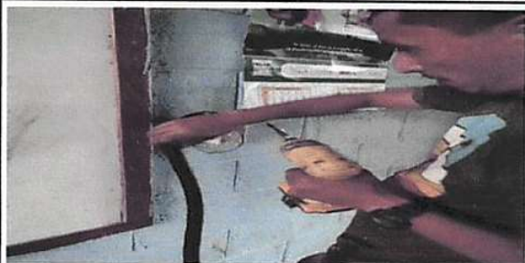
Foto 7: Sustitución interruptores dobles
