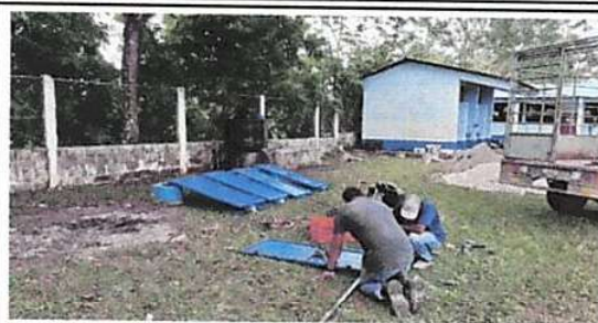
Foto 2: Mantenimiento a estructura (lijado, cambio de tubo , cepillado, sujeciones, aplicación de pintura) a puertas servicios sanitarios aplicación de pintura)
