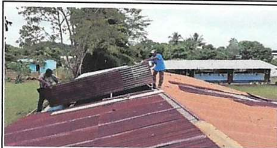
Foto1: Sustitución de lamina, por lamina troquelada aluzinc calibre 26 modulo de aulas
