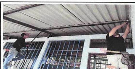
Foto 12: Sustitución de ducto eléctrico + accesorios
