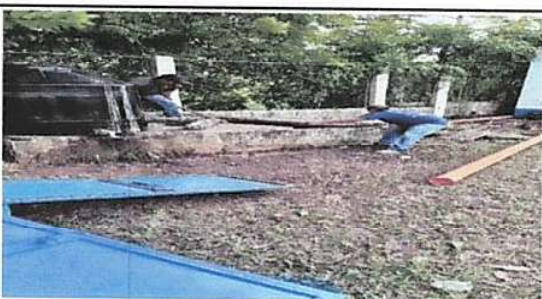
Foto 4: Limpieza de fosa séptica
