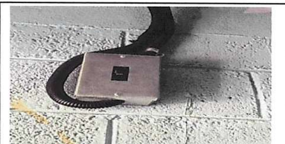
Foto 9: Sustitución de flipones
