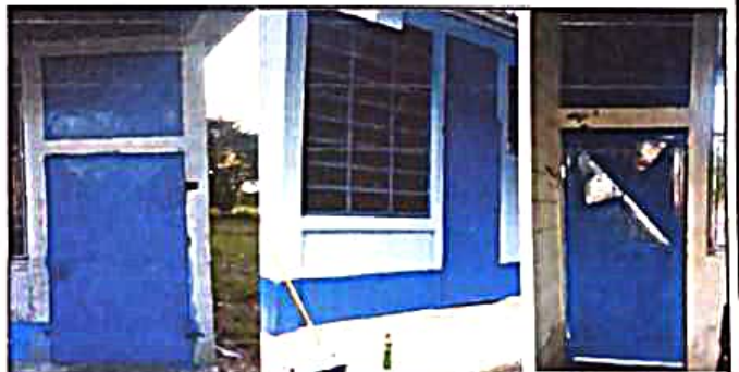
Foto 6: MANTENIMIENTO A ESTRUCTURA (LIJADO, CAMBIO DE TUBO, CEPILLADO, SUJECIONES, APLICACIÓN DE PINTURA)
