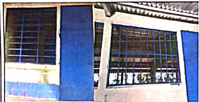
Foto 5: SUSTITUCION DE ESTRUCTURA DE METAL DE VENTANA
