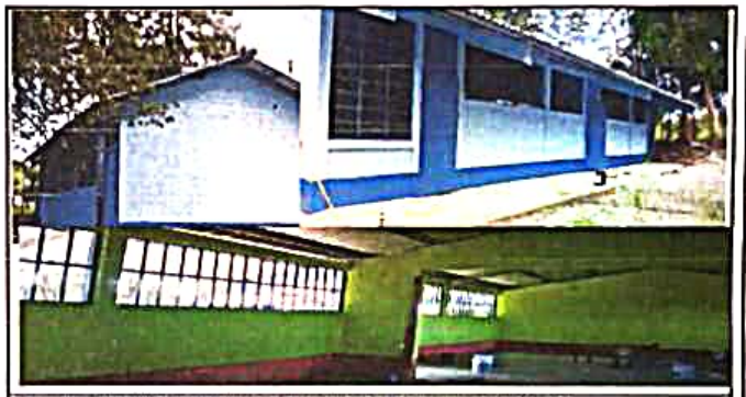
Foto 4: PINTURA EN MUROS EXTERIORES E INTERIORES
