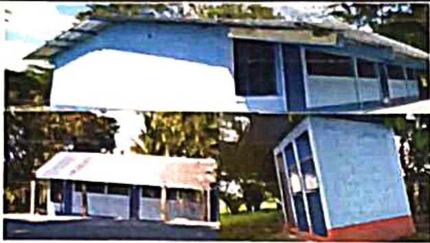
Foto 1: SUSTITUCION DE LÁMINA POR LÁMINA TROQUELADA ALUZINC CALIBRE 26
