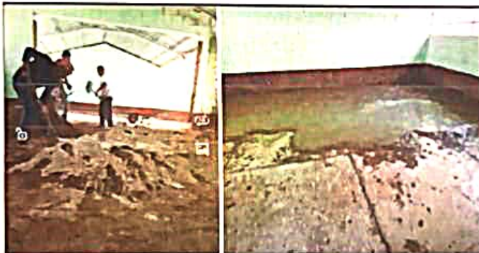
Foto 3: SUSTITUCION DE PISO DE CEMENTO LIQUIDO
