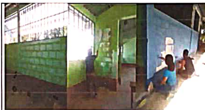
Foto 4: PINTURA EN MUROS EXTERIORES E INTERIORES
