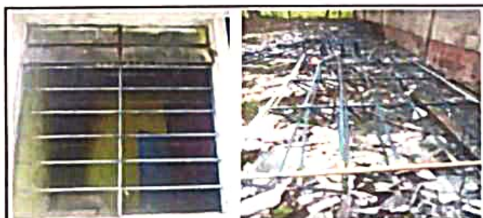
Foto 5: SUSTITUCION DE ESTRUCTURA DE METAL DE VENTANA
