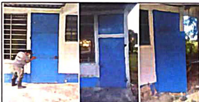
Foto 6: MANTENIMIENTO A ESTRUCTURA (LUJADO, CAMBIO DE TUBO, CEPILLADO, SUJECIONES APLICACIÓN DE PINTURA)
