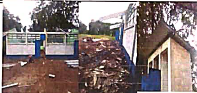
Foto 1: SUSTITUCION DE LAMINA, POR LAMINA TROQUELADA ALUZIC CALIBRE 26
