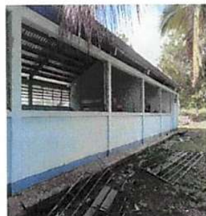
Foto 1: SUSTITUCION DE VIDRIOS
