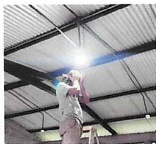
Foto 5: SUSTITUCION DE LAMPARA 2X40
