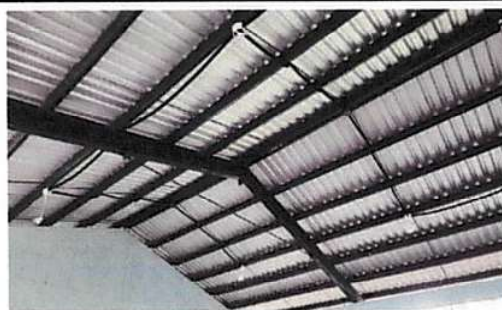
Foto 6: SUSTITUCION DE DUCTO ELECTRICO MAS ACCESORIOS
