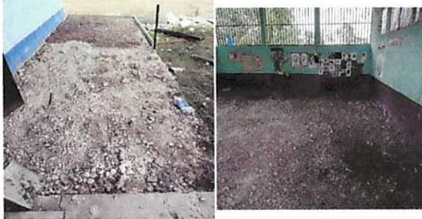
Foto 7: SUSTITUCION DE PISO DE CEMENTO LIQUIDO
