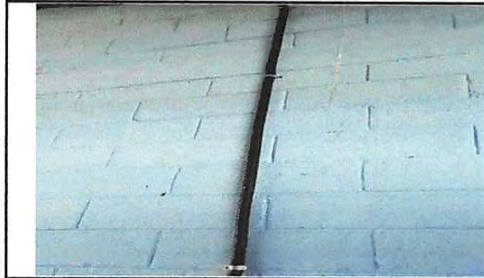
Foto19: Sustrucción de ducto eléctrico + accesorios
