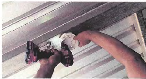
Foto13: Sustitución de plafoneras
