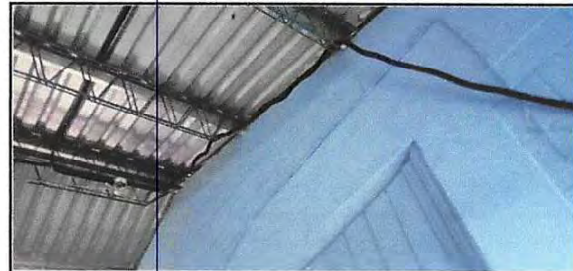
Foto 18: Reparación de cableado eléctrico
