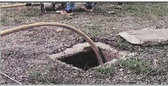
Foto 11: Limpieza de fosa séptica
