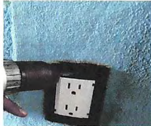
Foto 15:Sustitución de tomacorrientes dobles
