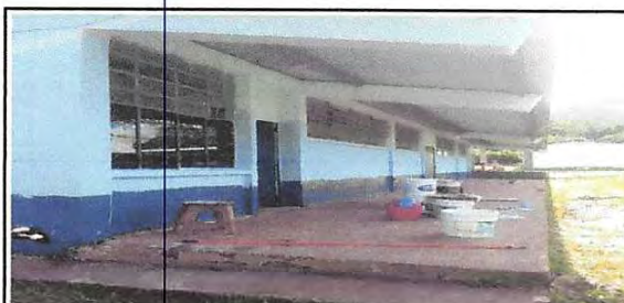
Foto 4: Pintura en muros exteriores e interiores
