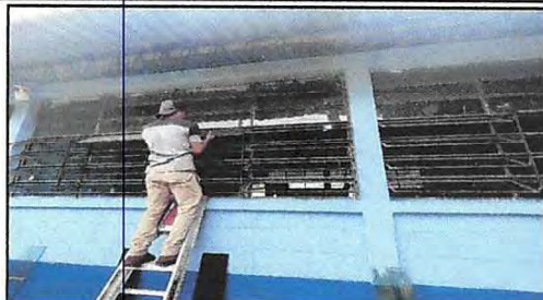
Foto 8: Sustrucción de vidrios
