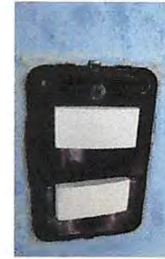
Foto 14:Sustitución interruptores dobles
