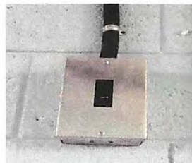
Foto 17:Sustitución de tablero de filpones
