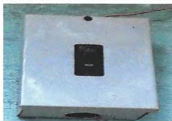
Foto 17: Sustrucción de tablero de flípones
