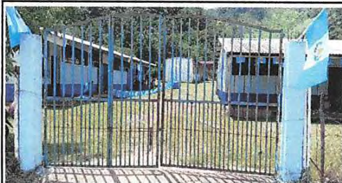
Foto 1: Mantenimiento a portones de metal
