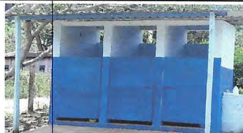
Foto 2: Mantenimiento a estructura puertas servicios sanitarios
