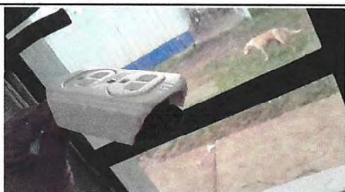
Foto 15: Sustrucción de tomacorrientes dobles
