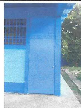
Foto 4: Mantenimiento a estructura (lijado, cambio de tubo, cepillado, sujeciones, aplicación de pintura)
