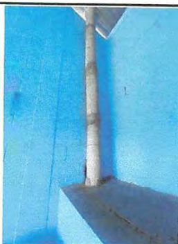
Foto13: Sustitución de chimenea de concreto.
