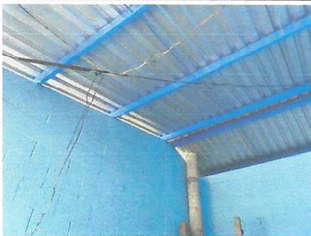
Foto 3: Mantenimiento a estructura de soporte de metal.
