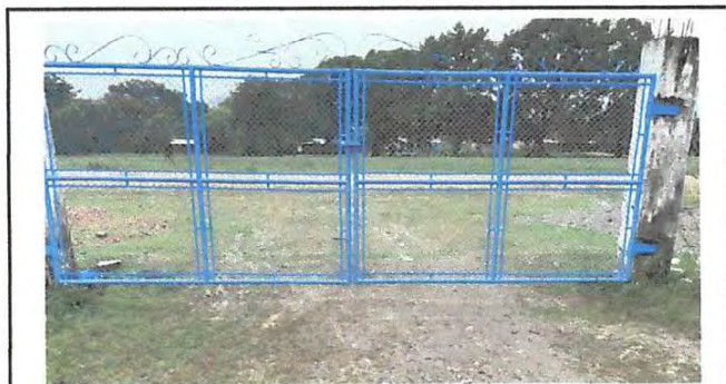
Foto7: Sustitución de portón de metal.
