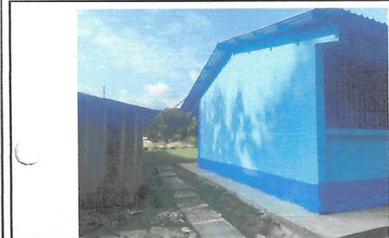
Foto 11: Pintura en muros exteriores e interiores.
