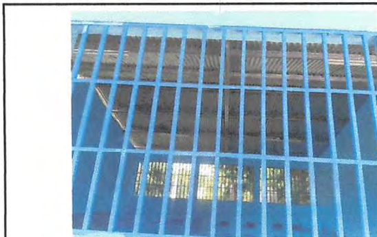
Foto 8: Mantenimiento a balcones de metal.
