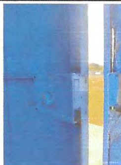
Foto 5: Sustitución de chapas.
