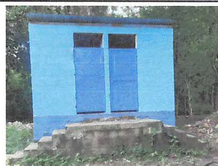
Foto 6: Sustitución de puerta en servicios sanitarios.
