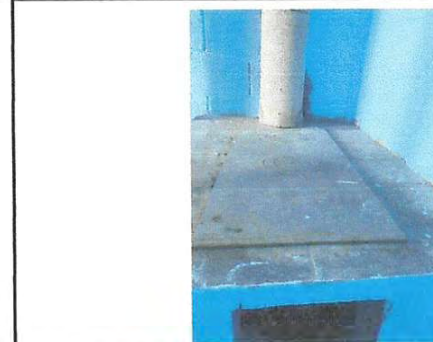
Foto 12: Sustitución de plancha de metal de 3 hornillas.
