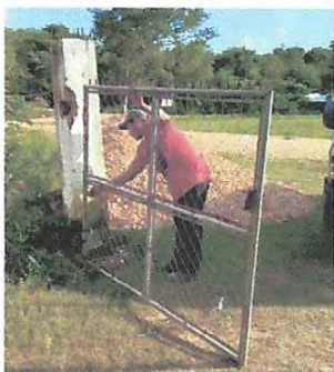
Foto7: Sustitución de portón de metal.
