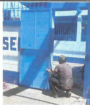
Foto 4: Mantenimiento a estructura (lijado, cambio de tubo, cepillado, sujeciones, aplicación de pintura)
