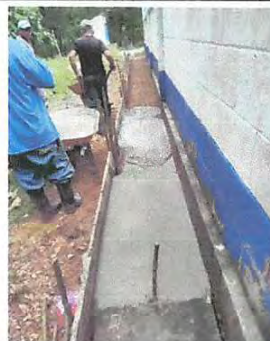
Foto 10: Reparación de banquetas de concreto.
