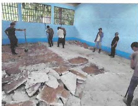
Foto 9: Reparación de piso de cemento líquido.
