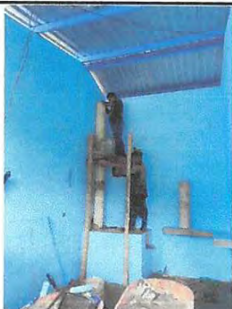
Foto13: Sustitución de chimenea de concreto.
