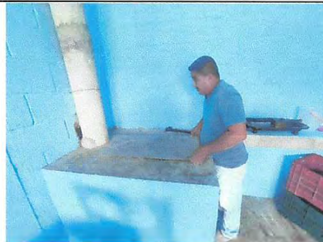
Foto 12: Sustitución de plancha de metal de 3 hornillas.
