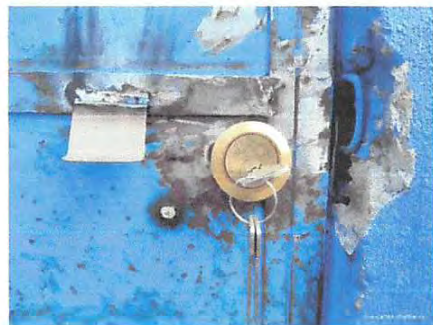
Foto 5: Sustitución de chapas.
