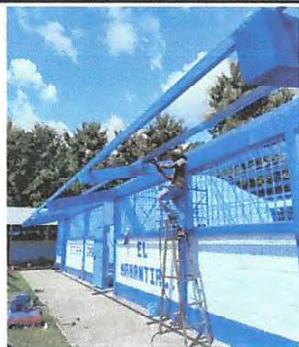
Foto 3: Mantenimiento a estructura de soporte de metal.
