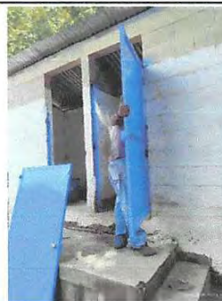
Foto 6: Sustitución de puerta en servicios sanitarios.
