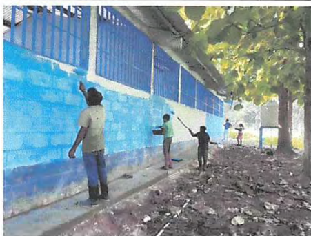
Foto 11: Pintura en muros exteriores e interiores.
