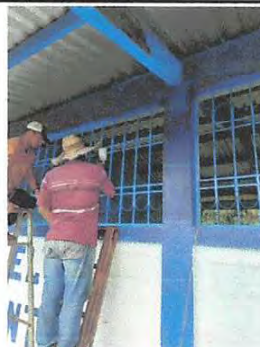
Foto 8: Mantenimiento a balcones de metal.
