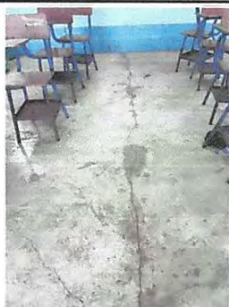
Foto 9: Reparación de piso de cemento líquido.
