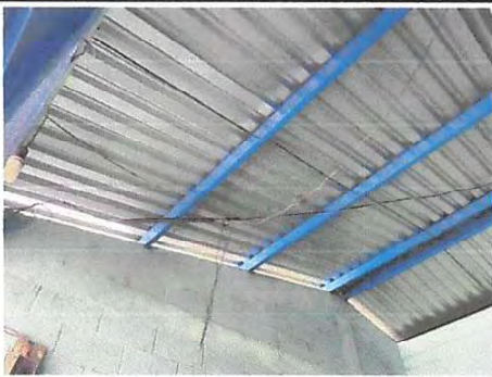
Foto 3: Mantenimiento a estructura de soporte de metal.
