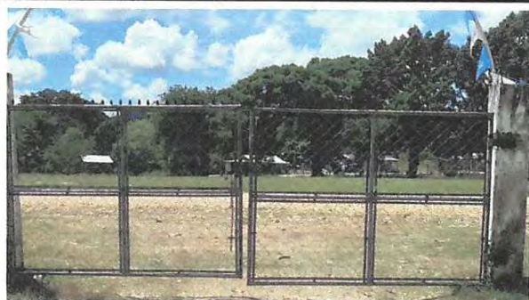
Foto 7: Sustrucción de portón de metal.
