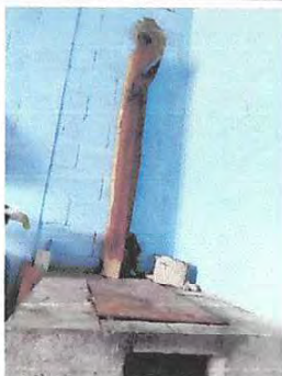
Foto13: Sustrución de chimenea de concreto.
