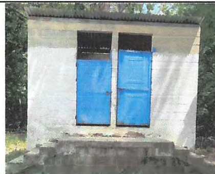
Foto 6: Sustrucción de puerta en servicios sanitarios.
