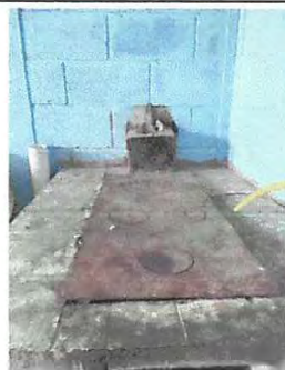
Foto 12: Sustrucción de plancha de metal de 3 hornillas.
