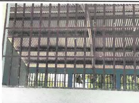
Foto 8: Mantenimiento a balcones de metal.
