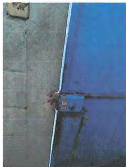
Foto 5: Sustrucción de chapas.
