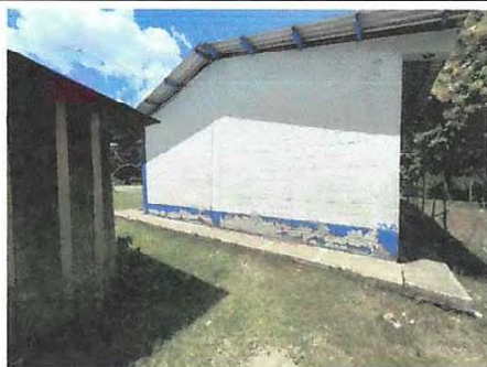
Foto 11: Pintura en muros exteriores e interiores.
