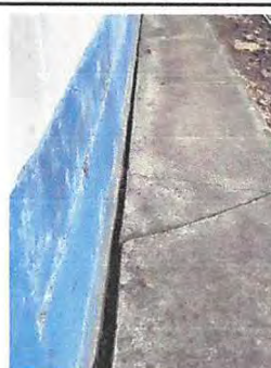
Foto 10: Reparación de banquetas de concreto.
