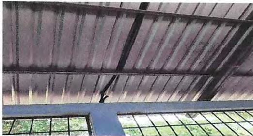
Foto 13: Reparación de cableado eléctrico
