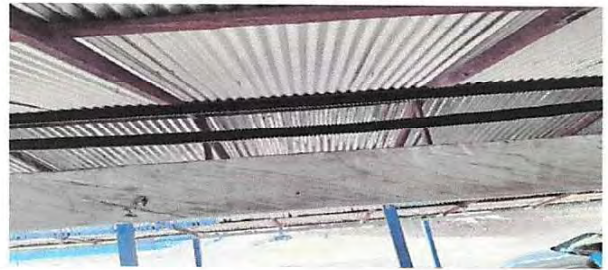
Foto 14: Sustitución de ducto eléctrico + accesorios
