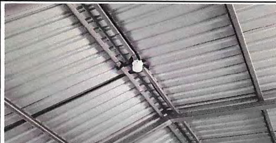
Foto 8: Sustrucción de focos ahorradores
