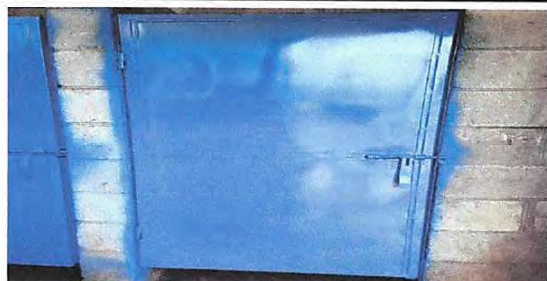
Foto 7: Sustrucción de puertas
