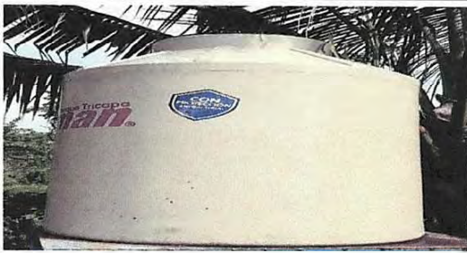
Foto 15: Sustitución de depósito de agua 1100 lt
