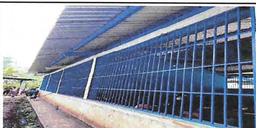
Foto 3: Mantenimiento a balcones de metal
