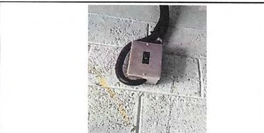
Foto 12: Sustrucción de flipones
