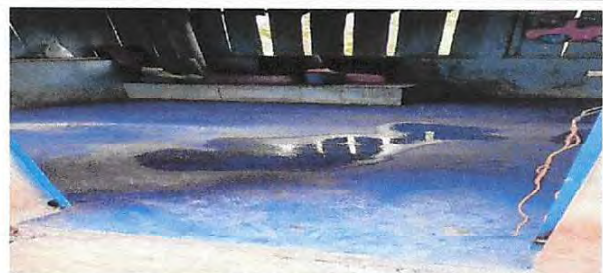
Foto 16: Sustitución de piso de torta de concreto
