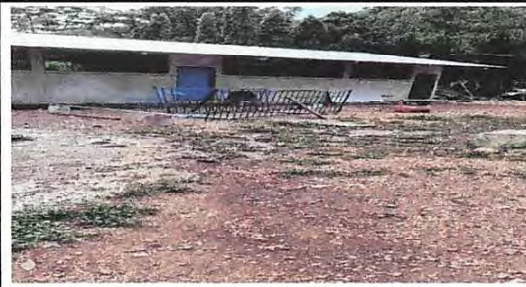
Foto 3: Mantenimiento a balcones de metal
