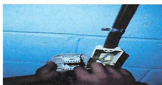
Foto 10: Sustrución intrruptores dobles
