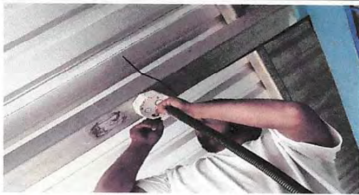
Foto 13: Reparación de cableado eléctrico
