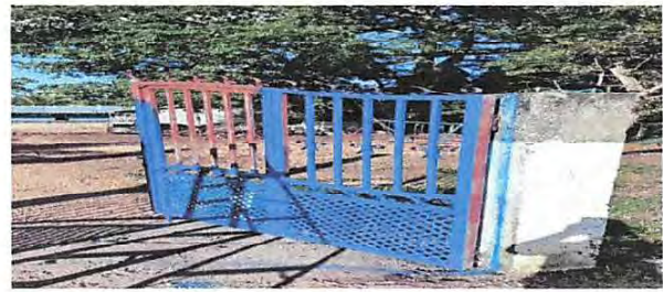
Foto 4: Mantenimiento a portones de metal
