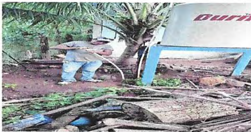
Foto 15: Sustitución de depósito de agua 1100 lt
