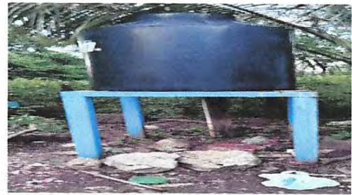
Foto 15: Sustitución de depósito de agua 1100 lt
