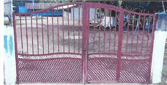
Foto 4: Mantenimiento a portones de metal
