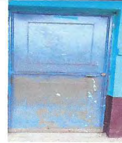
Foto 2: Mantenimiento a estructura (lijado, cambio de tubo, cepillado, sujeciones, aplicación de pintura)
