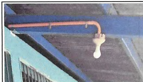
Foto 9: Sustrución de plafoneras
