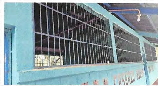
Foto 3: Mantenimiento a balcones de metal
