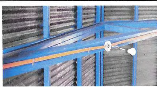
Foto 8: Sustrución de focos ahorradores
