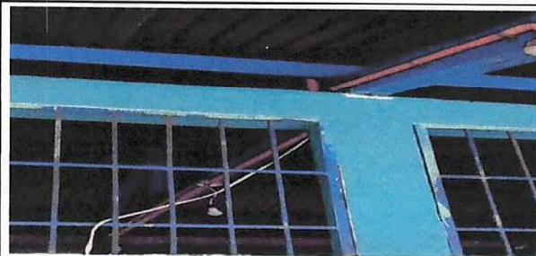
Foto 14: Sustitución de ducto eléctrico + accesorios
