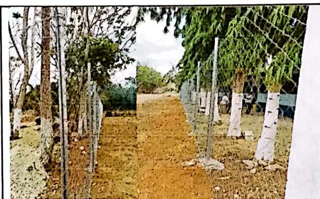
Renglon No. 5: Fotos del proyecto de sustitucion del cerco de madera por malla metalica y tubos de metal y alambre espigado, ya finalizado.
