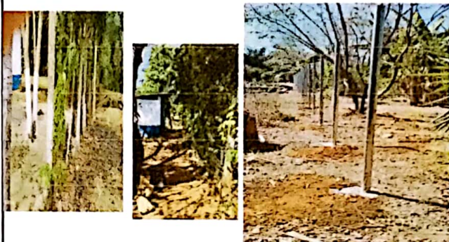
Renglon No. 5: Fotos de antes,durante del proyecto de sustitucion del cerco de madera por malla metalica y tubos de metal y alambre espigado.
