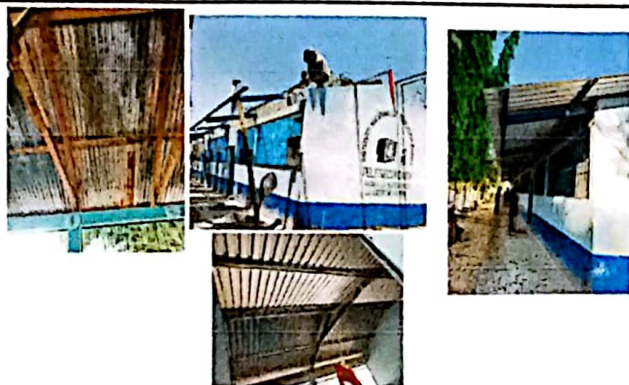
Renglon No. 1. Estas fotos son del proceso del proyecto del cambio del techo de la estructura de madera por metal y la lamina por troquelada,
