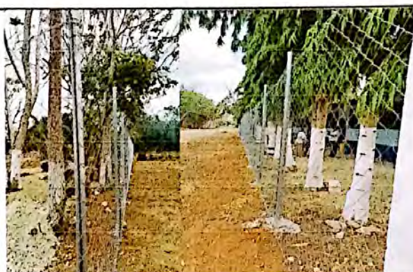
Renglon No. 5: Fotos del proyecto de sustitucion del cerco de madera por malla metalica y tubos de metal y alambre espigado, ya finalizado.
