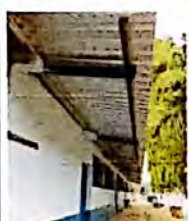
Renglon No. 1. Estas fotos son del proyecto del cambio del techo de la estructura de madera por metal y la lamina por troquelada, finalizado.
