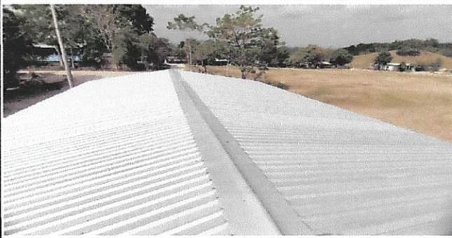
Foto 1: Cubierta de lámina
