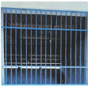
Foto 3: Sustitución de balcones de metal de 2 aulas.
