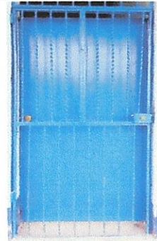
Foto 2: Sustitución de puertas de metal con chapa, de 2 aulas.
