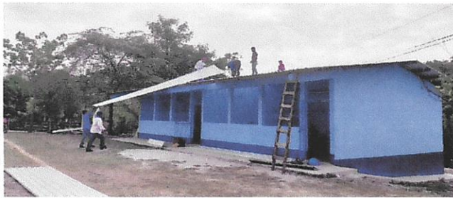
Foto 1: Cubierta de lámina
