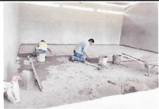
Foto 4: Sustitución de piso, por piso cerámico para 2 aulas.
