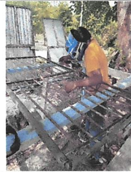
Foto 2: Sustitución de puertas de metal con chapa, de 2 aulas.
