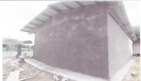
Foto 6: Reparación de repello y cernido de paredes
