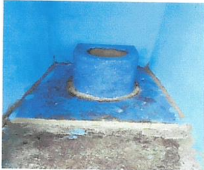
SUSTITUCIÓN DE INODORO
