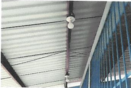
SUSTITUCIÓN DE PLAFONERAS
