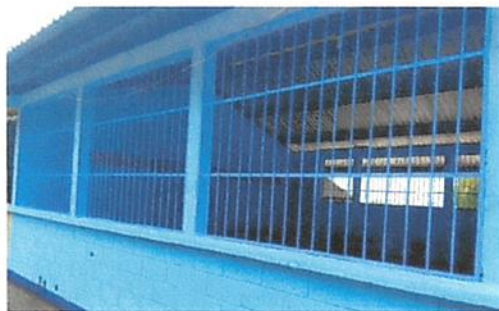
SUSTITUCIÓN DE BALCON DE METAL
