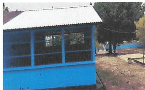
SUSTITUCIÓN DE CAPOTE
