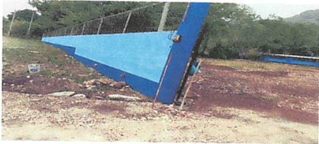
PINTURA EN MUROS
