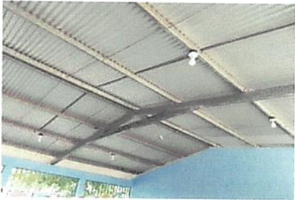
SUSTITUCIÓN DE FOCOS
