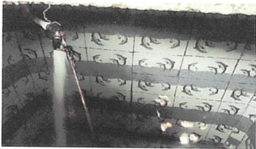
REPARACIÓN DE CISTERNA DE CONCRETO
