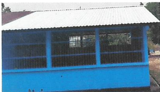
SUSTITUCIÓN DE LÁMINA
