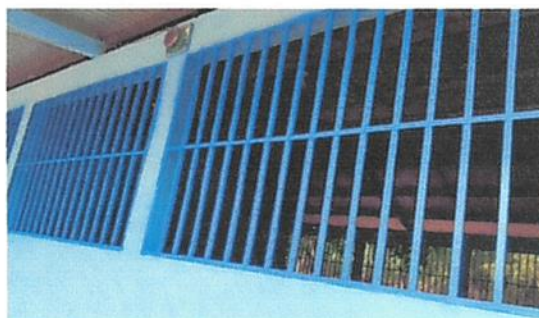
MANTENIMIENTO A BALCONES DE METAL
