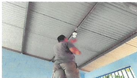
SUSTITUCIÓN DE FOCOS
