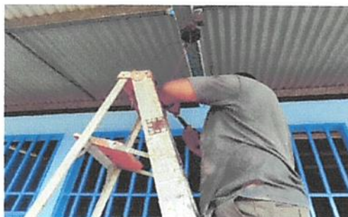
SUSTITUCIÓN DE PLAFONERAS
