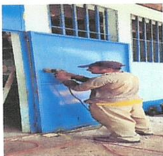
MANTENIMIENTO A PUERTAS
