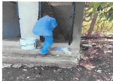
SUSTITUCIÓN DE INODORO
