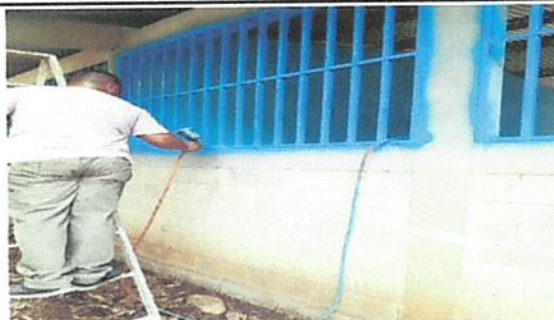
MANTENIMIENTO A BALCONES DE METAL
