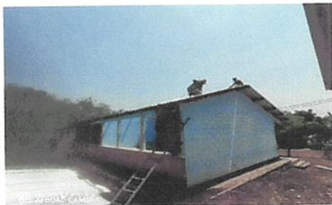
INSTALACIÓN DE LÁMINA
