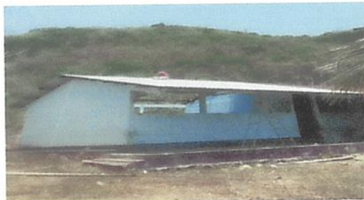
INSTALACIÓN DE CAPOTES
