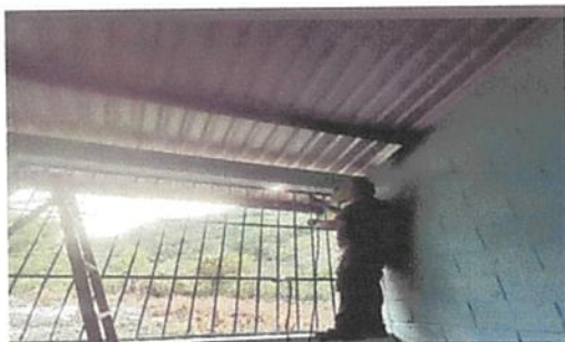
FABRICACIÓN E INSTALACIÓN DE BALCONES DE METAL
