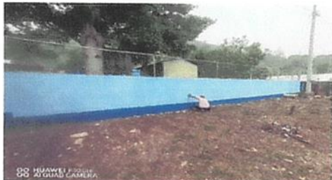
PINTURA EN MUROS INTERIORES Y EXTERIORES
