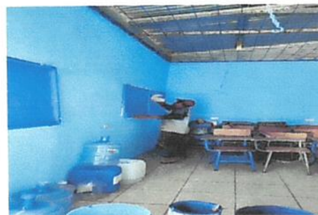
MANTENIMIENTO A VENTANAS DE BALCÓN
