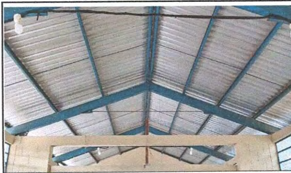
Foto 11: reparación de cableado eléctrico
