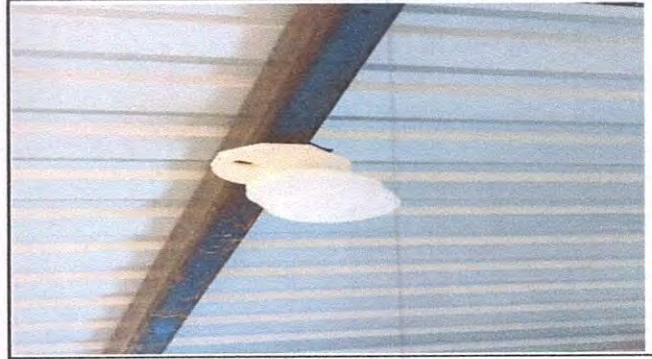
Foto 8: Sustrución de plafoneras
