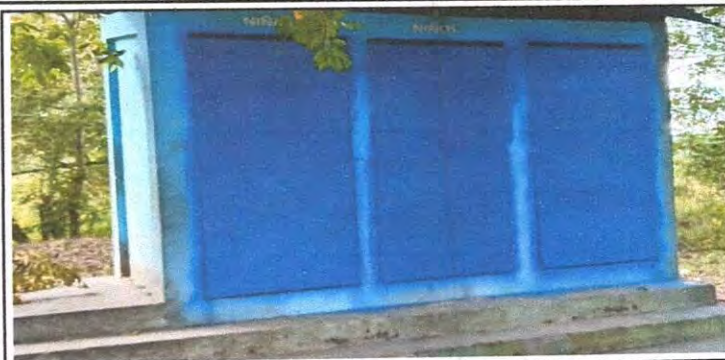
Foto 2: Mantenimiento a estructura (lijado, cambio de tubo , cepillado, sujeciones, aplicación de pintura) a puertas de servicios sanitarios
