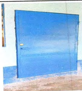
Foto 2: Mantenimiento a estructura (lijado, cambio de tubo , cepillado, sujeciones, aplicación de pintura) a puertas de servicios sanitarios
