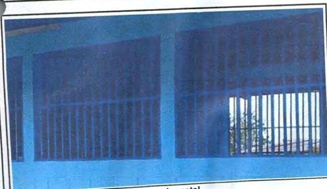
Foto 5: Mantenimiento de balcones de metal
