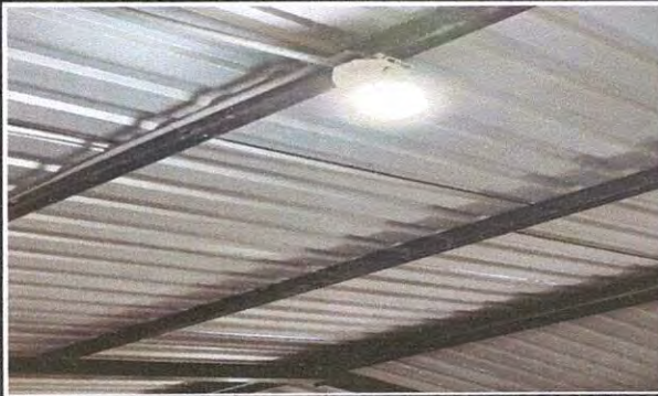
Foto 7: Sustrución de Focos ahorradores
