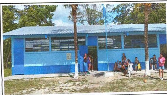
Foto 3: Pintura en muros exteriores e interiores
