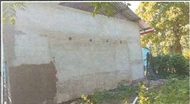
Foto 13: Repello en muro
