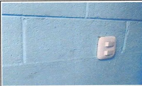
Foto 9: Sustrución de Interruptores dobles
