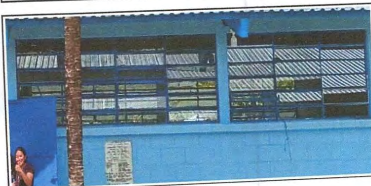
Foto 6: Sustitucion de vidrios
