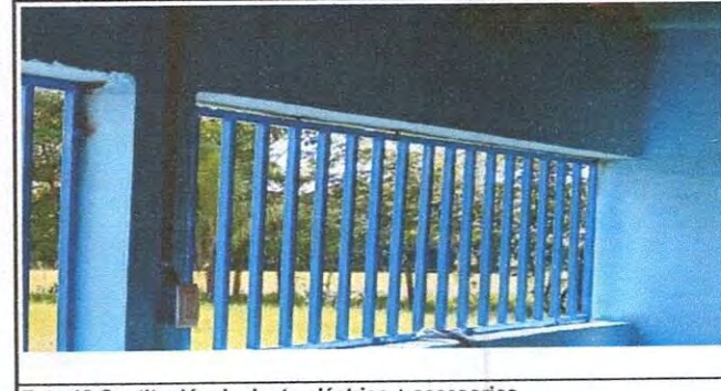
Foto 12: Sustrución de ducto eléctrico + accesorios
