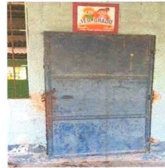
Foto 2: Mantenimiento a estructura (lijado, cambio de tubo , cepillado, sujeciones, aplicacion de pintura) a puertas de servicios sanitarios
