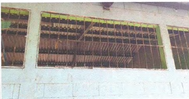
Foto 5: Mantenimiento de balcones de metal
