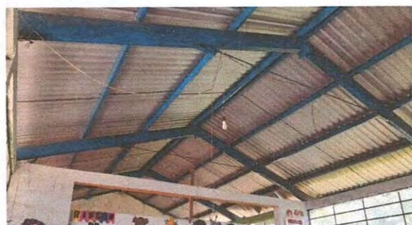
Foto 11: reparación de cableado eléctrico
