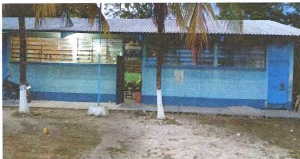
Foto 3: Pintura en muros exteriores e interiores
