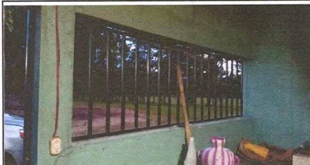
Foto 12: Sustrución de ducto eléctrico + accesorios
