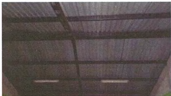
Foto 7: Sustrución de Focos ahorradores
