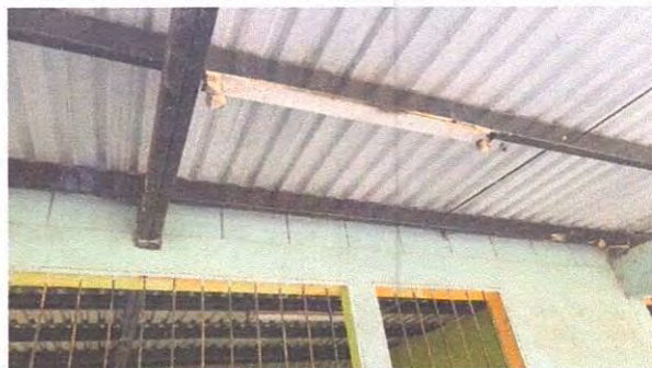
Foto 8: Sustrución de plafoneras
