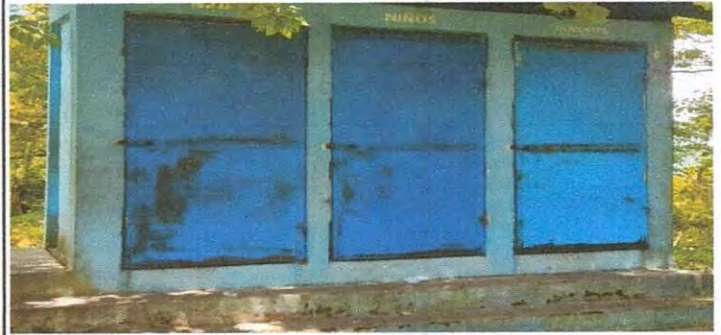
Foto 2: Mantenimiento a estructura (lijado, cambio de tubo , cepillado, sujeciones, aplicacion de pintura) a puertas de servicios sanitarios
