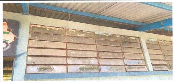
Foto 6: Sustrucción de vidrios
