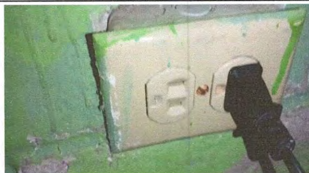
Foto 10: Sustrución de tomacorriente dobles
