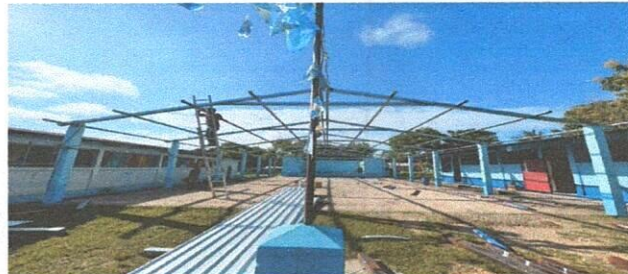
Foto 6:Desinstalación de lámina existente
