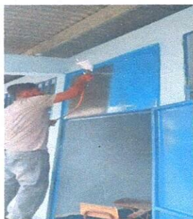
Foto 3:Mantenimiento a estructura (lijado, cambio de tubo , cepillado, sujeciones, aplicación de pintura) a puerta de aulas
