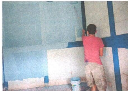
Foto 4: Pintura en muros exteriores e interiores
