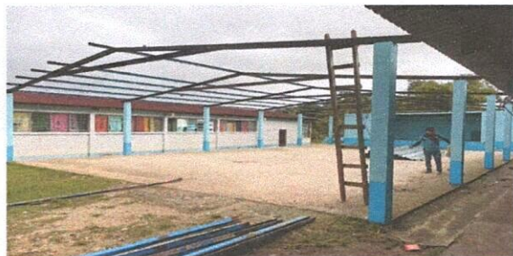
Foto 5:Desinstalación de estructura portante
