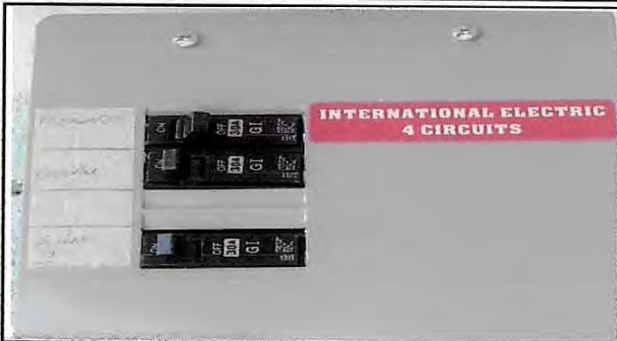
Foto 13: Sustrucción de flípones
