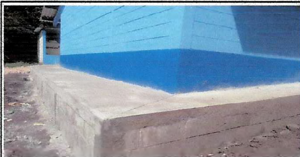
Foto 5: Reparación de banquetas de concreto
