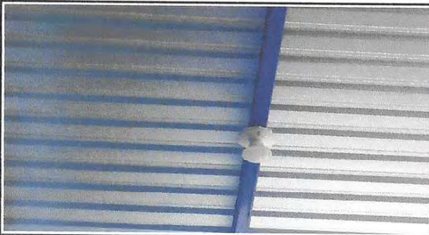
Foto 9: Sustitución de focos ahorradores
