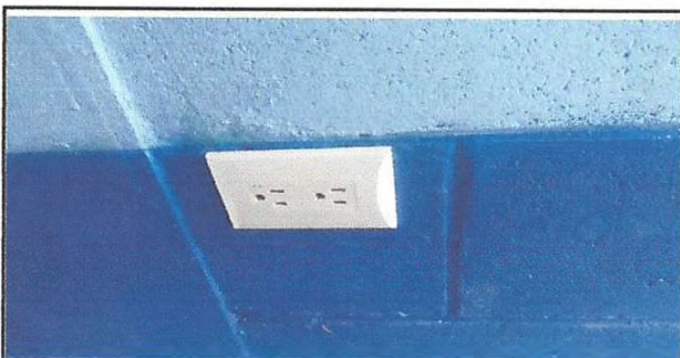
Foto 12: Sustitución de tomacorrientes dobles
