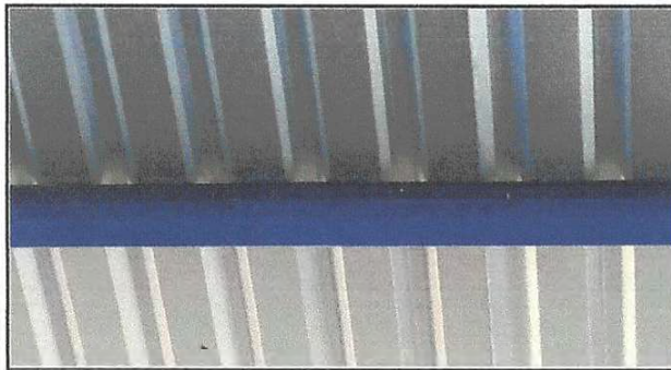
Foto 3: Sustitución de elementos de fijación.
