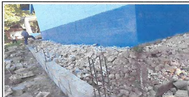
Foto 5: Reparación de banquetas de concreto
