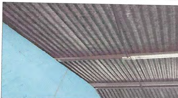
Foto 4: Mantenimiento a estructura de soporte de metal
