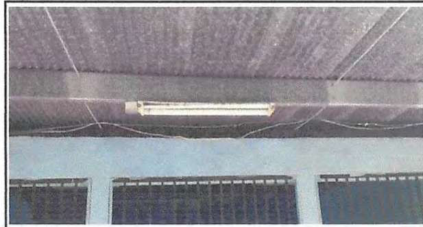
Foto 10: Sustrucción de plafoneras
