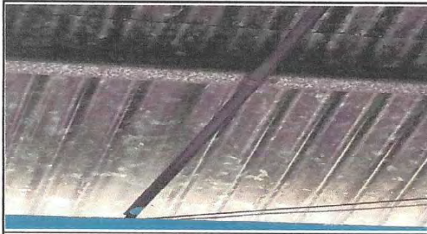
Foto 15: Sustitución de ducto eléctrico + accesorios
