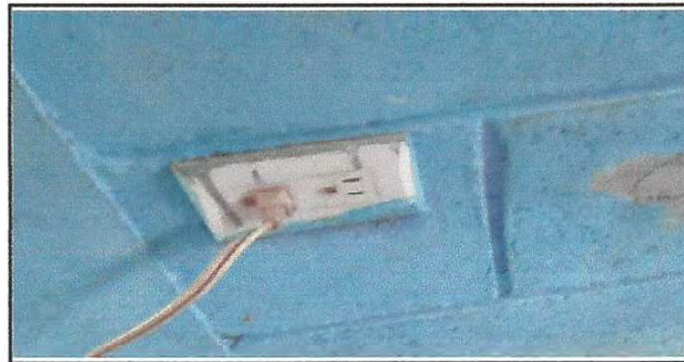
Foto 12: Sustrucción de tomacorrientes dobles
