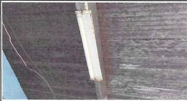
Foto 9: Sustrucción de focos ahorradores
