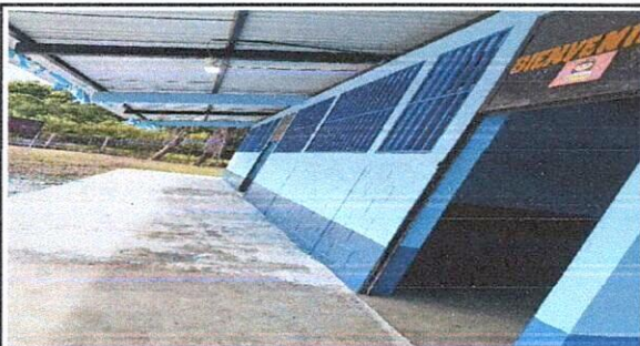
Foto1: Mantenimiento a balcones de metal
