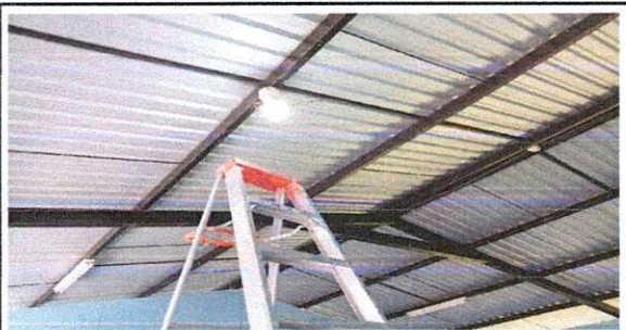
Foto 5: Sustitución de focos ahorradores
