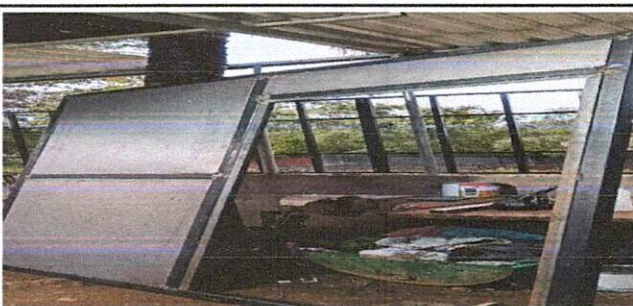
Foto 6: Sustitución de porton de metal
