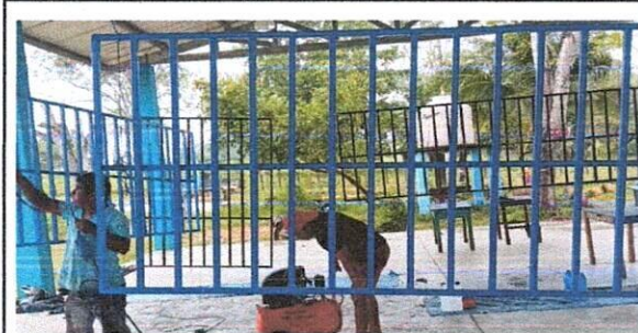
Foto1: Mantenimiento a balcones de metal
