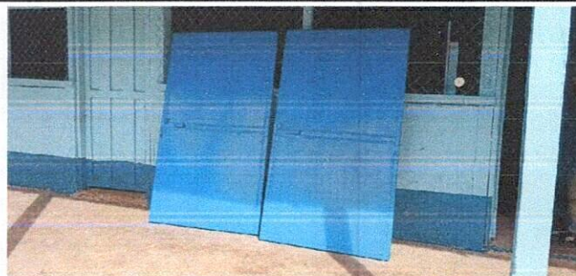
Foto 2: Sustitución de puerta
