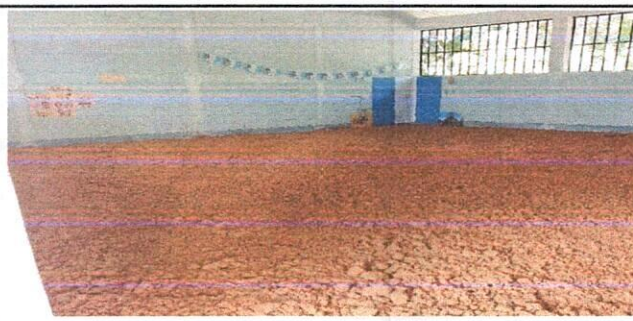
Foto 4: Sustitución de piso de torta de concreto
