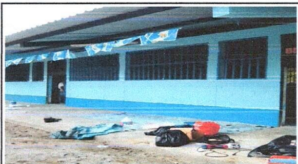
Foto 3: Pintura en muros exteriores e interiores
