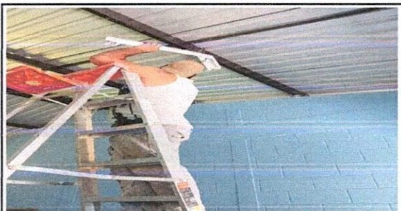
Foto 5: Sustitución de focos ahorradores
