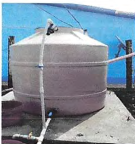
Foto 17: Sustrucción de depósito de agua de 1100 lt
