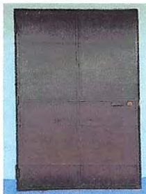
Foto 5: Mantenimiento a estructura de metal
