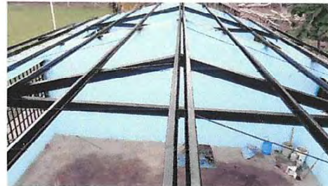
Foto 4: Mantenimiento a estructura de soporte de metal
