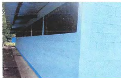
Foto 10: Pintura en muros exteriores e interiores
