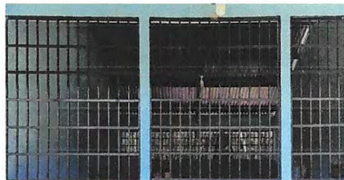
Foto 8: Mantenimiento de balcones de metal
