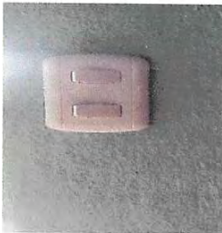
Foto 13: Sustrucción de interruptores dobles
