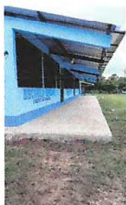
Foto 9: Reparación de piso de torta de concreto
