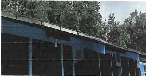
Foto 19: Sustrucción de canales de metal
