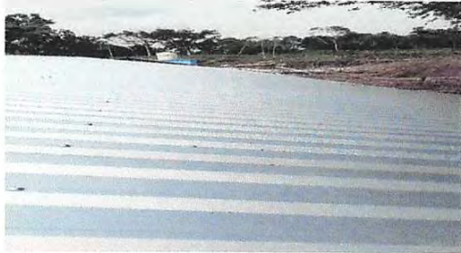
Foto 1: Sustrucción de lámina por lámina troquelada aluzinc
