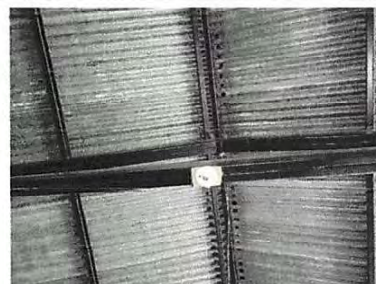
Foto 12: Sustrucción de plafoneras
