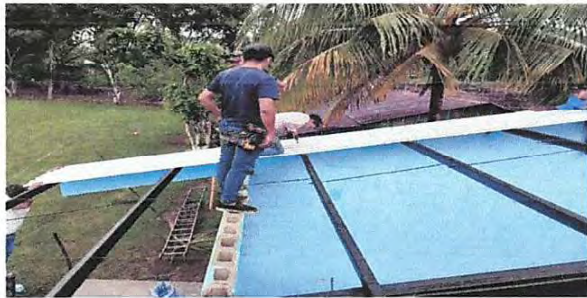
Foto1: Sustitución de lámina por lámina troquelada aluzinc
