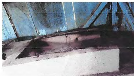
Foto 18: Sustitución de plancha de metal de 3 hornillas
