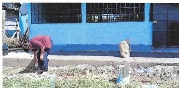
Foto 9: Reparación de piso de torta de concreto
