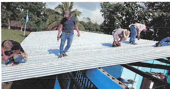
Foto 3: Sustitución de elementos de fijación
