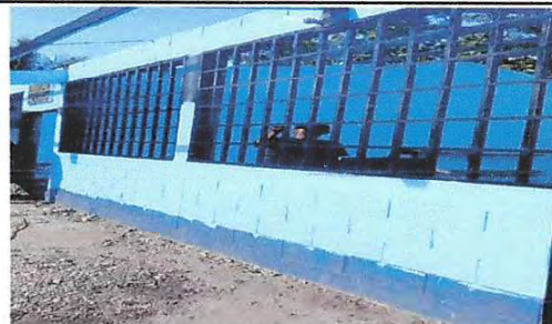
Foto 8: Mantenimiento de balcones de metal
