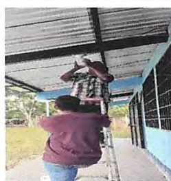
Foto 11: Sustitución de lámparas tipo Led
