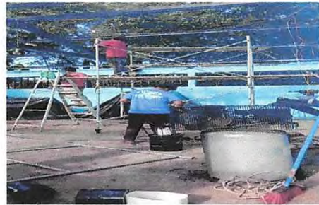
Foto 4: Mantenimiento a estructura de soporte de metal
