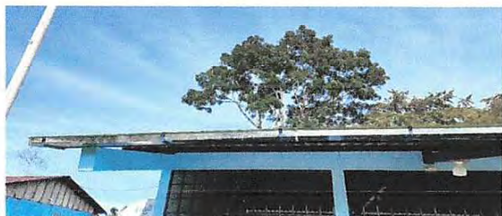
Foto 19: Sustrucción de canales de metal
