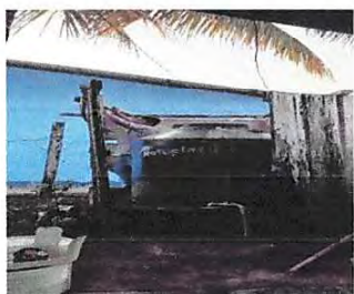
Foto 17: Sustitución de depósito de agua de 1100 lt
