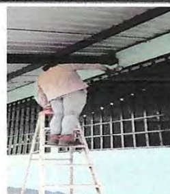
Foto 12: Sustitución de plafoneras
