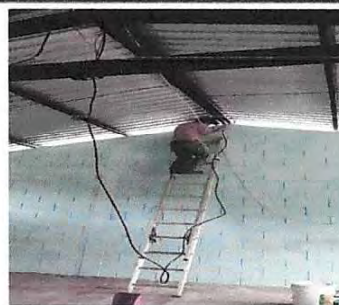
Foto 16: Reparación de cableado eléctrico
