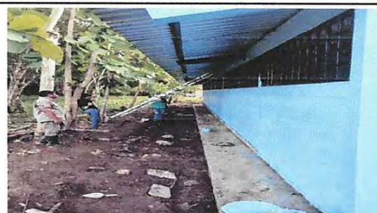
Foto 10: Pintura en muros exteriores e interiores
