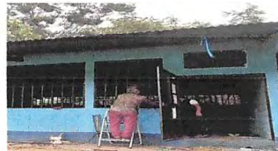
Foto 6: Sustitución de chapas
