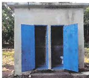
Foto 7: Sustrucción de puertas de servicios sanitarios
