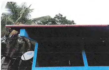
Foto 19: Sustitución de canales de metal
