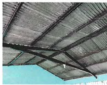
Foto 4: Mantenimiento a estructura de soporte de metal
