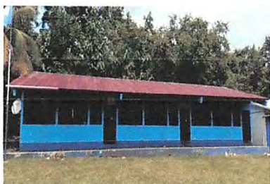
Foto 1: Sustrucción de lámina por lámina troquelada aluzinc
