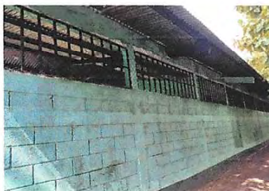
Foto 10: Pintura en muros exteriores e interiores
