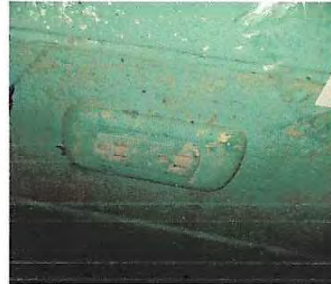
Foto 14: sustrucción de tomacorrientes dobles
