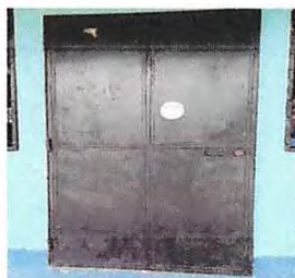
Foto 5: Mantenimiento a estructura de metal
