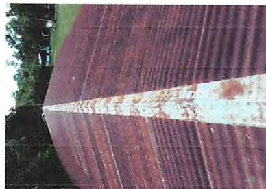
Foto 2: Sustrucción de capote de lámina, para lámina troquelada
