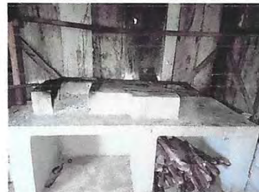
Foto 18: Sustrucción de plancha de metal de 3 hornillas
