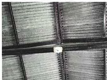
Foto 12: Sustrucción de plafoneras
