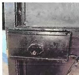
Foto 6: Sustrucción de chapas
