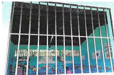
Foto 8: Mantenimiento de balcones de metal
