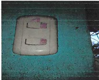
Foto 13: Sustrucción de interruptores dobles
