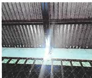
Foto 11: Sustrucción de lámparas tipo Led
