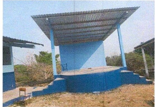
REPARACIÓN DE MURO
