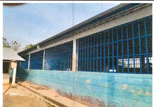
SUSTITUCIÓN DE BALCONES
