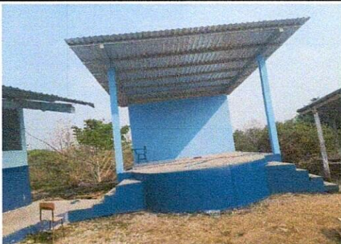
REPELLO EN MURO
