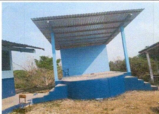
SUSTITUCION DE LAMINA, POR LAMINA TROQUELADA ALUZINC CALIBRE 26
